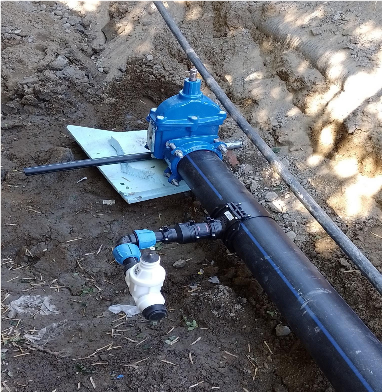
Keskustien saneerauksen yhteydessä uusittiin myös 1990 -luvun alussa rakennettu runkovesijohto liittymineen
