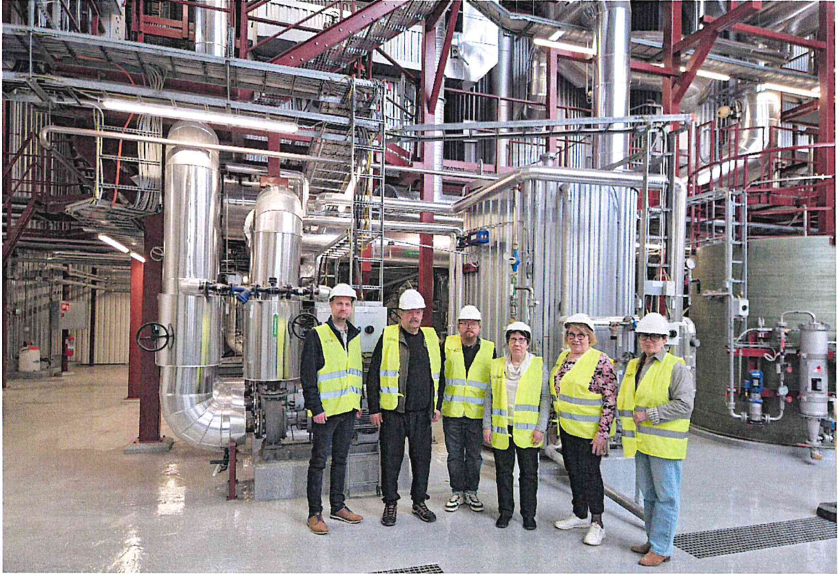
Tarkastuslautakunta tutustumiskäynnillä Nurmeksen Lämpö Oy:n uudella lämpölaitoksella 15.4.2026. Kuvassa (vasemmalta) Tuomo Sirviö, Jorma Tiainen, Teemu Mikkola, Merja Jaaranen, Anna Hölttä ja Ritva Mahlavuori.
