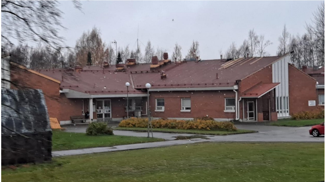
Kuva: Terveyskeskuksen katto remontti toteutettiin vuoden 2021 aikana.
