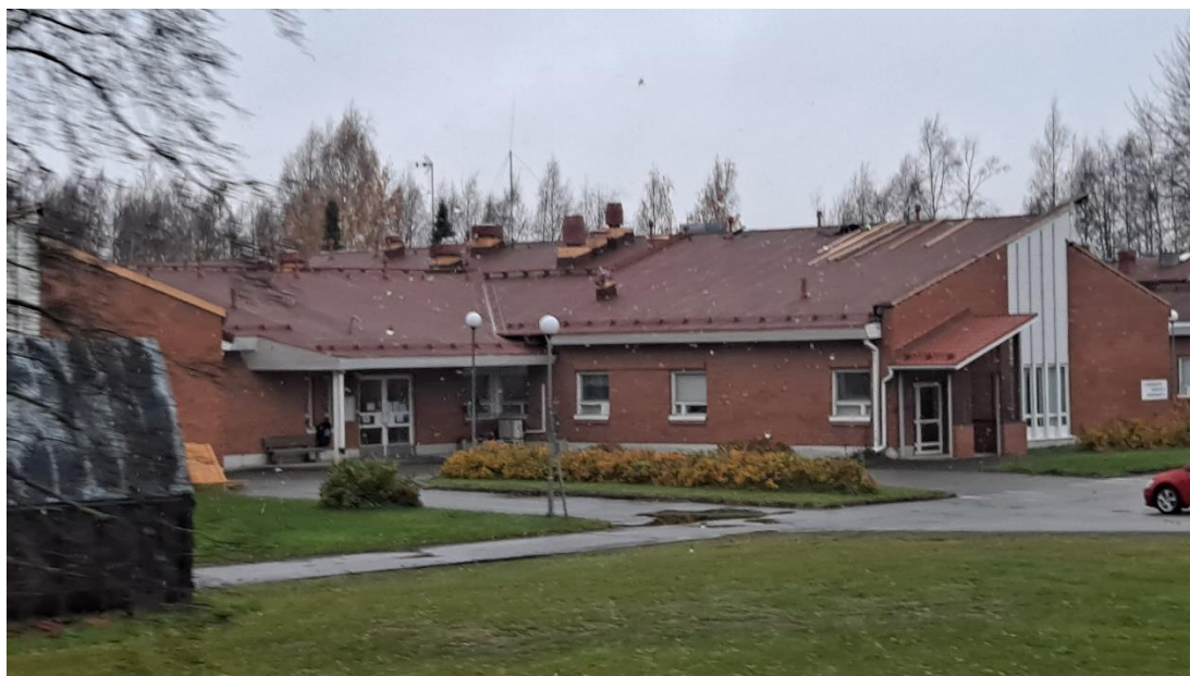
Kuva: Terveyskeskuksen kattoremontti toteutettiin vuoden 2021 aikana.
