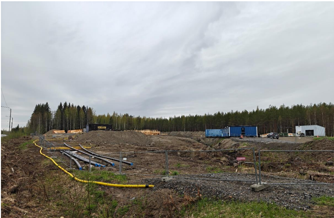
Kuva: Jätevedenpuhdistamon työmaa-alue 23.5.2025. Kuvaaja: Ritva Simonen
