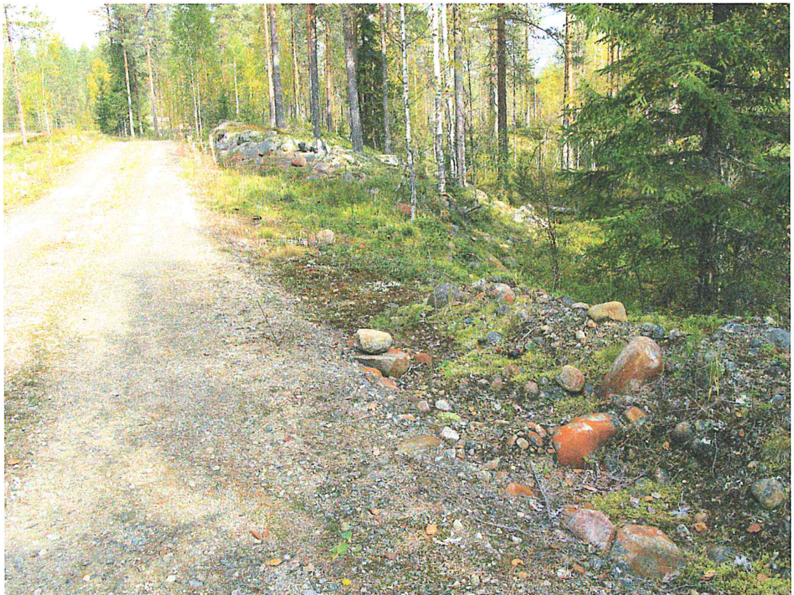
Kuva 3. Ottamisalueen B:n eteläosan keskivaiheilta pohjoisen suuntaan.
