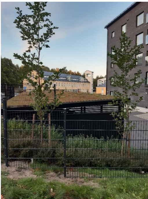
Kuva 8. Esimerkkikuva Lahdessa sijaitsevan kerrostalon parkkikatoksesta, jossa on käytetty viherkattoa.
