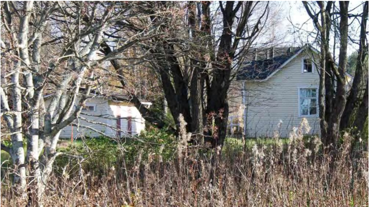
Kuva 19 Lepolan puretun mökin länsijulkisivu ja piharakennus. Kuvälähde: FCG, 2016.
