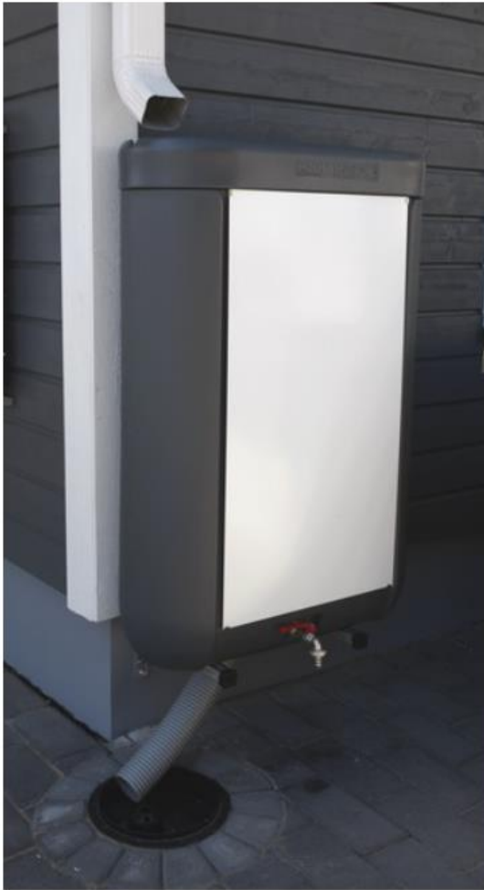
Kuva 10. Kattovesien kerääminen säiliöön (Kuva: Rakentaja.fi).
