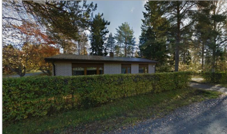
Kuva 4. Riihivaarantien 1 1-kerroksinen vuonna 1976 rakennettu rakennus.
