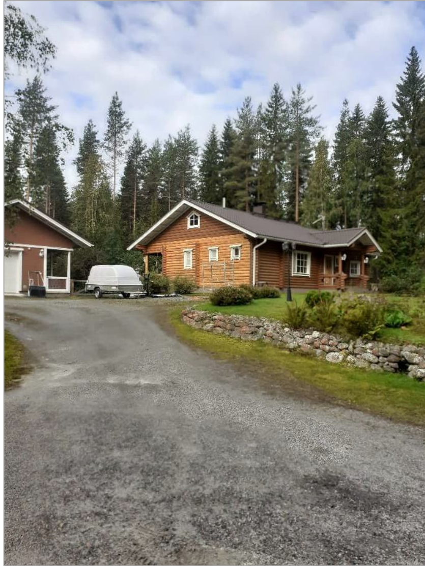
Kuva 15. Loimutie 12:ssa on hirsitalo, joka on valmistunut vuonna 1999.
