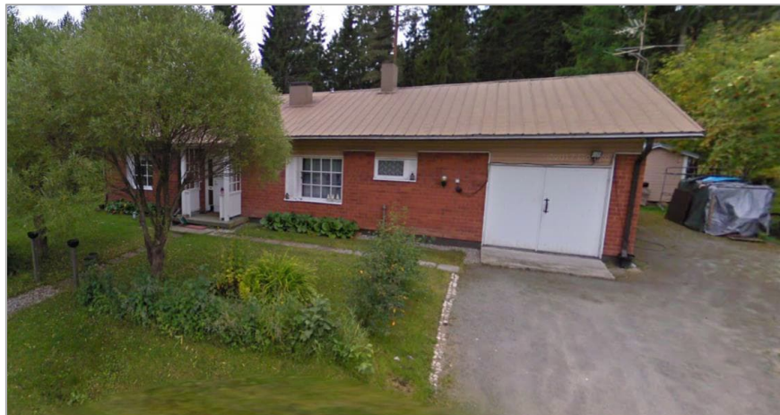
Kuva 12. Punainen tiili- ja lautaverhoiltu asuinrakennus Liekkitie 2:ssa, mikä on valmistunut vuonna 1982.
