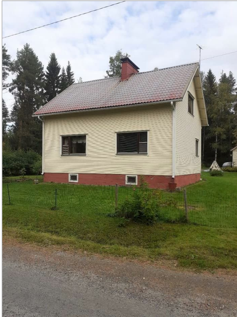
Kuva 16. Sahatie 2 rintamiestyypinen asuinrakennus vaalealla laudoituksella, ja se on valmistunut vuonna 1952. Rakennus on osa kaupunki- ja kyläkuvallisesti tärkeää aluetta (sk).
