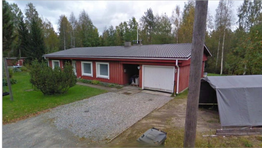
Kuva 13. Punainen puuverhoiltu asuinrakennus Sepäntie 19, mikä on valmistunut vuonna 1981.
