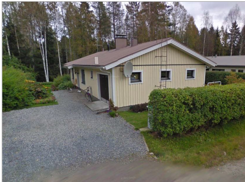
Kuva 10. Vaalea 1-kerroksinen asuinrakennus Savutie 5, mikä on valmistunut vuonna 1988.
