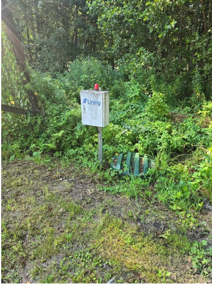
Kuva 8 Kiinteistökohtainen pumppaamo
