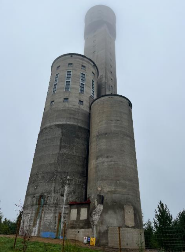
Kuva 3. Keretin kaivostorni kuvattuna syyskuussa 2023.
