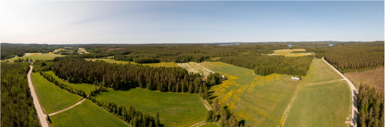
Kuva 48. Pohjoisosa, länteen, 120 m korkeus.
