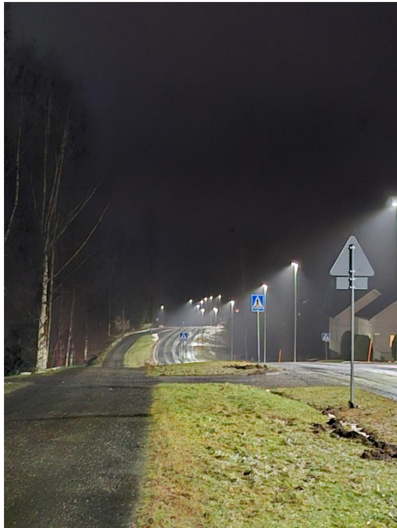
Kuva: Asemantien uudet katuvalot oli yksi tilikauden investointikohteista. Kuvaaja: Matti Ikonen
