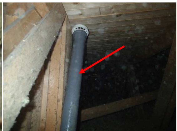
Kuva 20. F-osa, yläpohjan eristämätön viemärin tuuletusputki.
