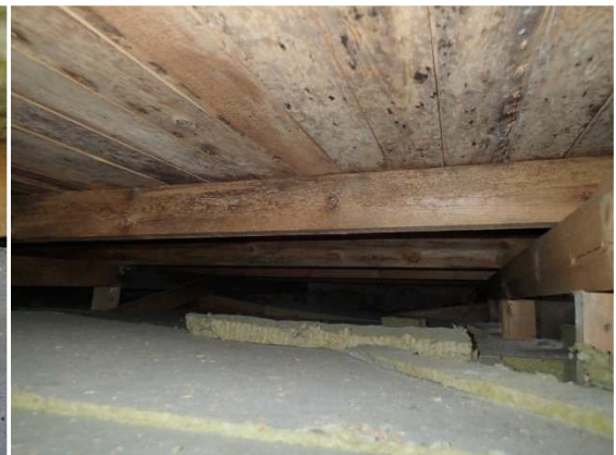
Kuva 18. G-osa, yläpohjan aluslaudoituksessa näkyvää mikrobikasvustoa.
