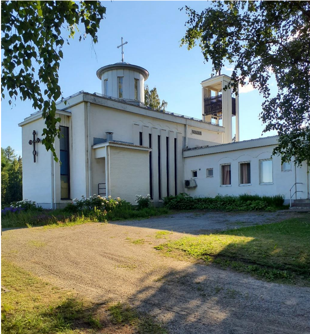
Kuva 4-22. Lintulan luostarin kirkkorakennusta alueen puistosta katsottuna. Luostarin pihapiiri on sulkeutunut runsaan puuston, rakennusten ja muurien vuoksi.
