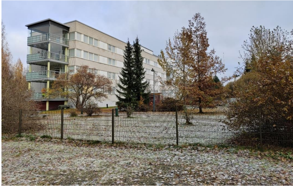
Kuva 4. Uusin, nyt jo purettu sairaalarakennus syksyllä 2023.
