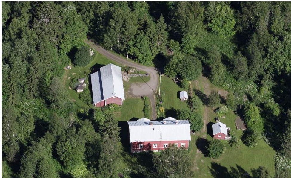
Kuva 7. Kaava-alueella sijaitsee yksityisessä omistuksessa olevia rakennuksia.
