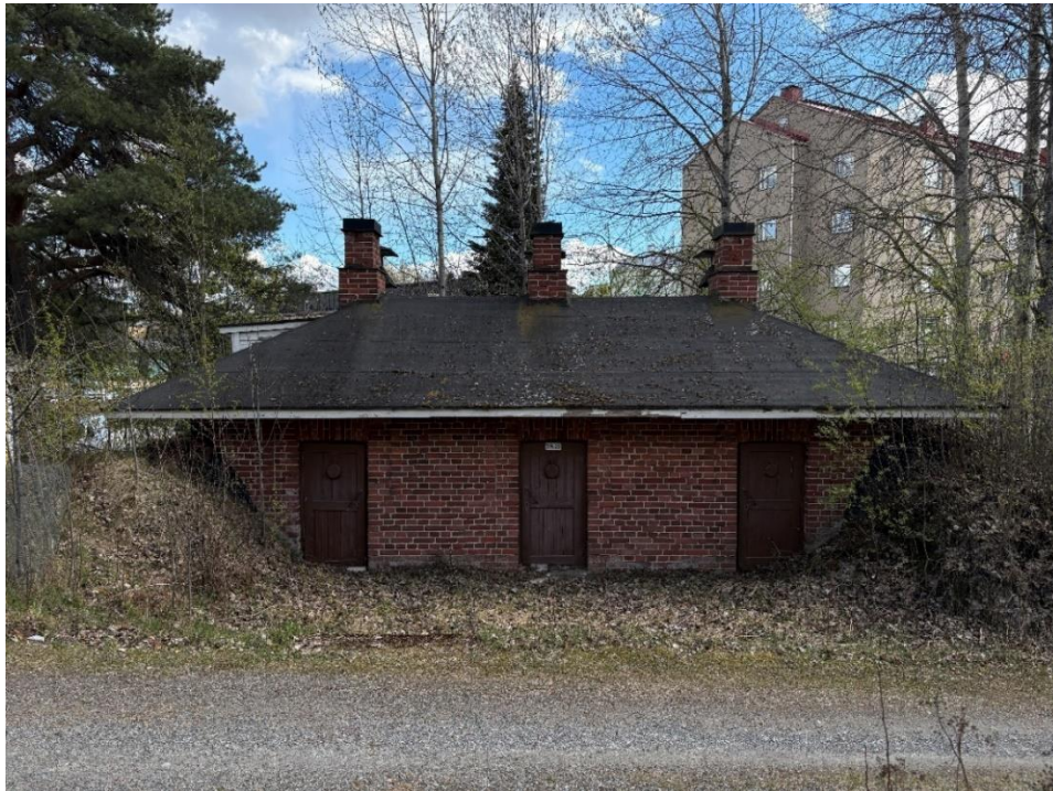
Kuva 5. Tiilinen kellarirakennus on myös ollut kuuden perheen asuintalon asukkaiden käytössä.
