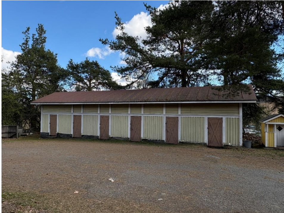
Kuva 4. Talousrakennus oli jaettu kuuden perheen asuintalon huoneistojen kesken.
