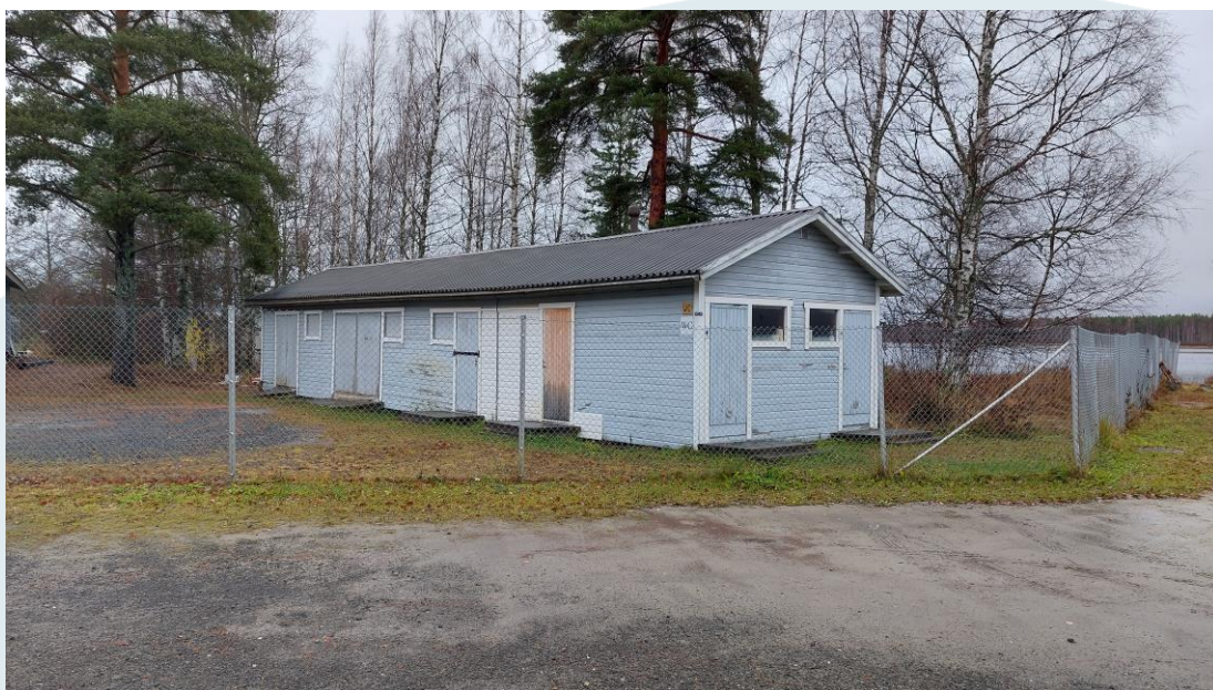
Kuva 14 Rantakenttä, pesäpallostadion. Vanha huoltorakennus.
