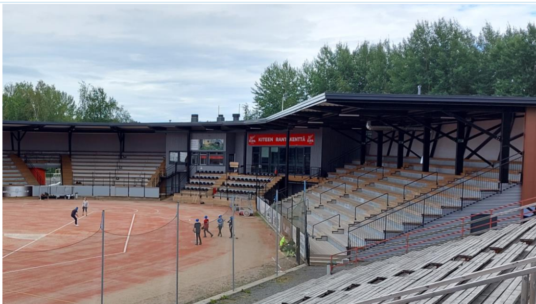
Kuva 13 Rantakenttä, pesäpallostadion. Huoltorakennus stadionin keskiosassa.
