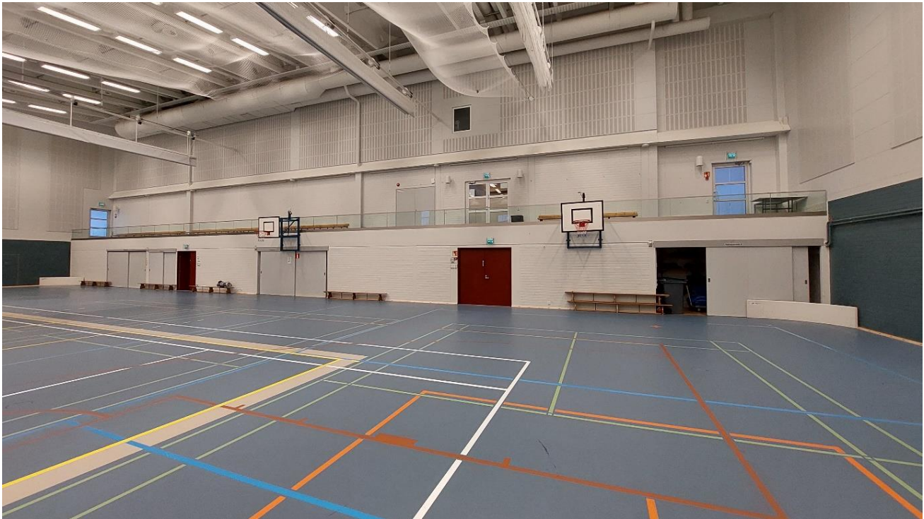
Vespelin liikuntasalin lattian pinnoite uusittiin vuoden 2022 aikana.
