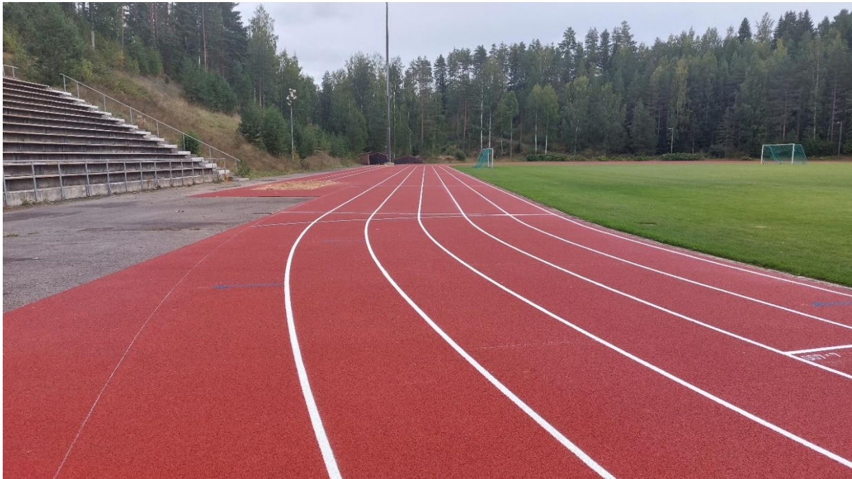
Hutsin urheilukentän pinnoite uusittiin vuoden 2022 aikana.
