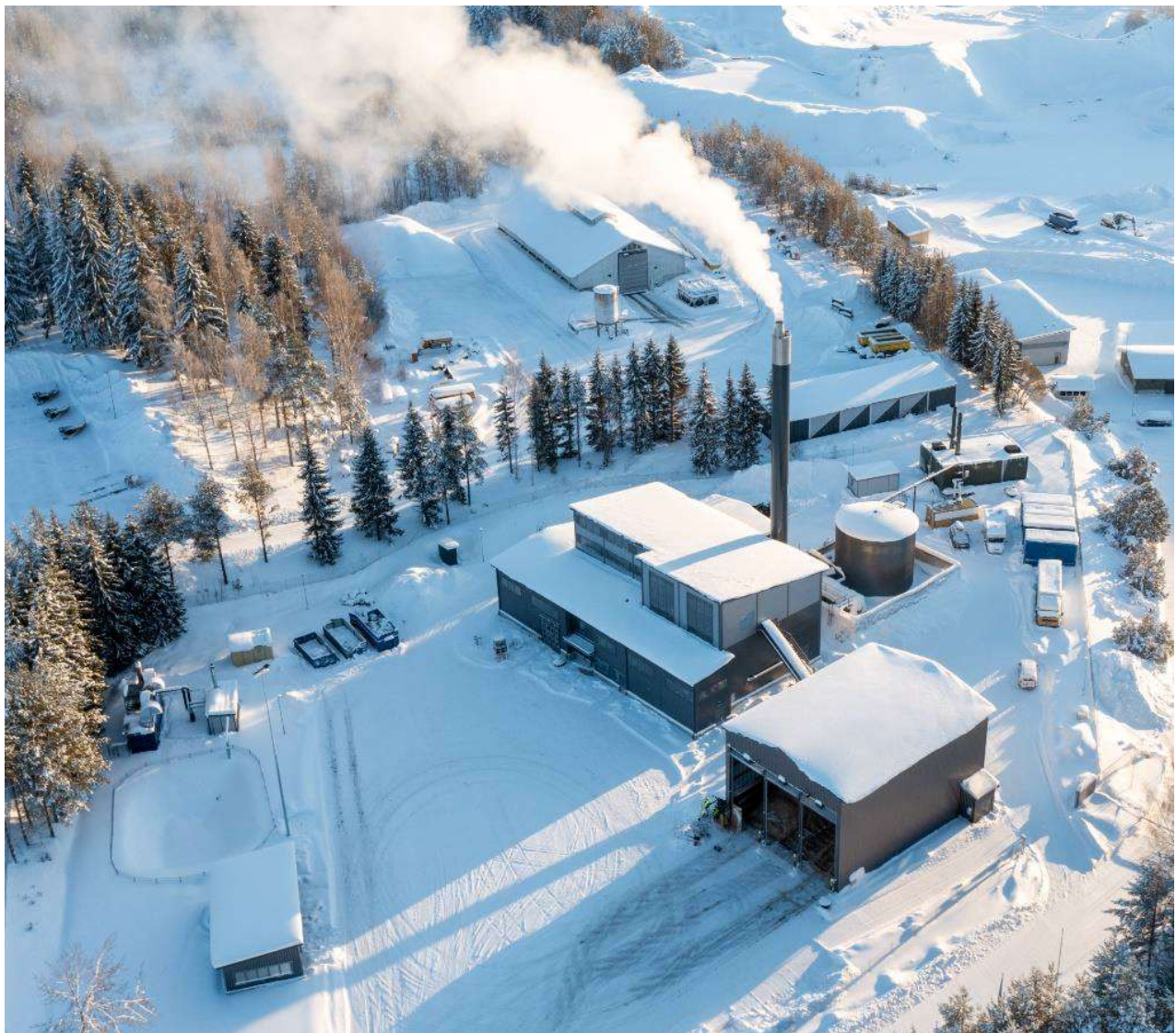
Kiteen Lämmön uusi Arppen lämpölaitos.
