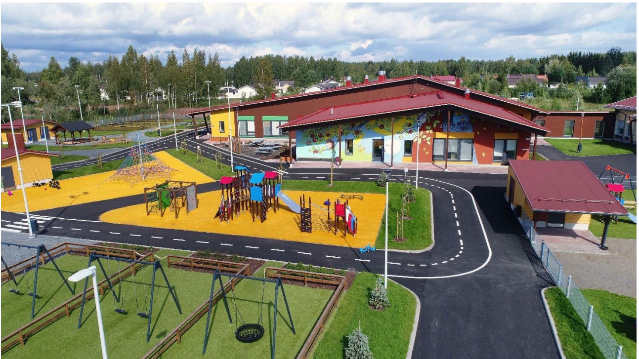
Aamuvirkun päiväkotikoti valmistui vuoden 2021 aikana.
