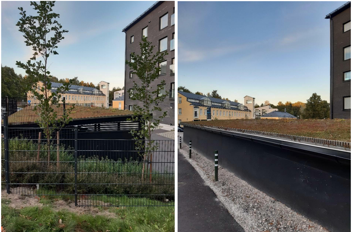
Kuva 11. Esimerkkikuva Lahdessa sijaitsevan kerrostalon parkkikatoksesta, jossa on käytetty viherkattoa.
