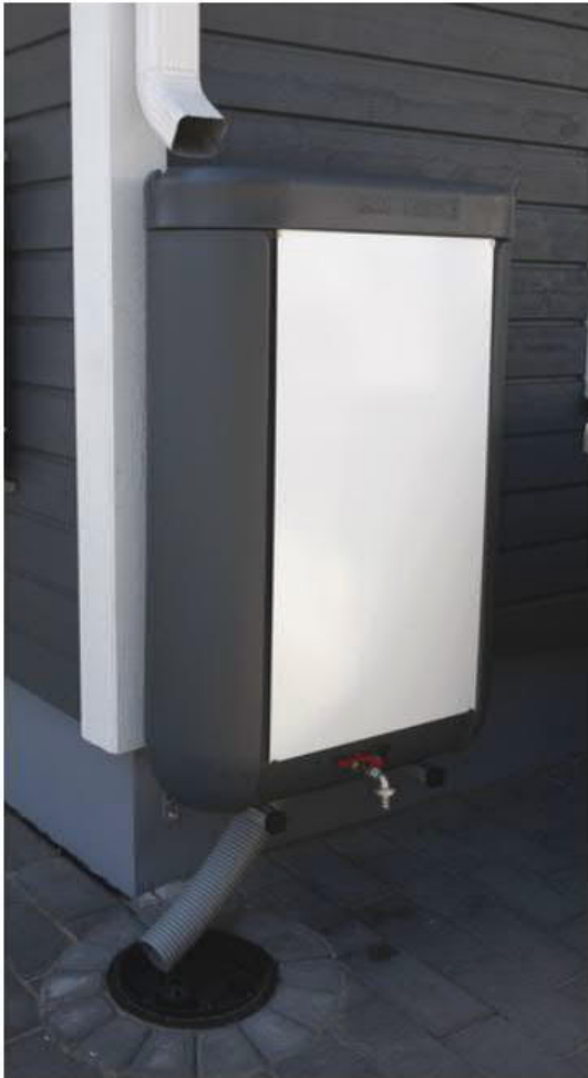
Kuva 10. Kattovesien kerääminen säiliöön (Kuva: Rakentaja.fi).
