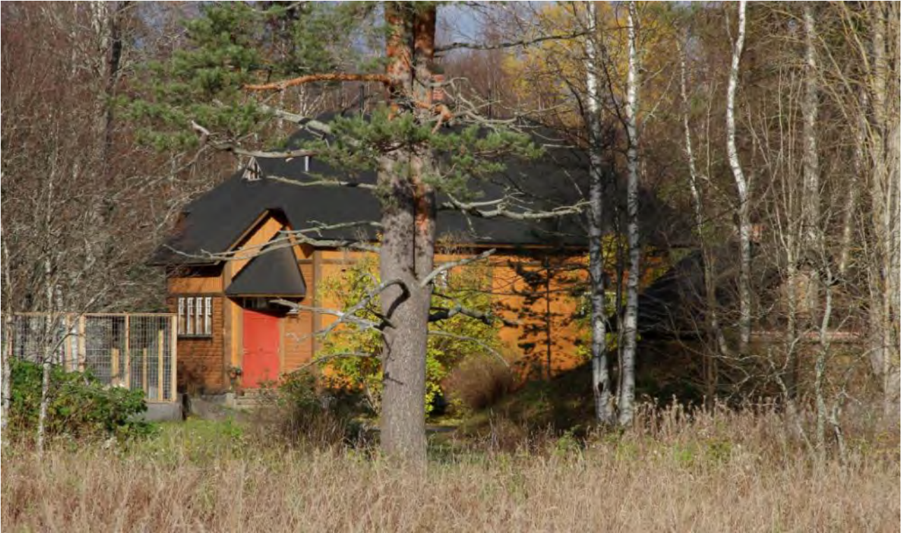
Kuva 13. Asemavartijan talo koulun urheilukentän suunnalta kuvattuna. Vasemmalla näkyy puretun piharakennuksen perustukset, oikealla maakellari.
