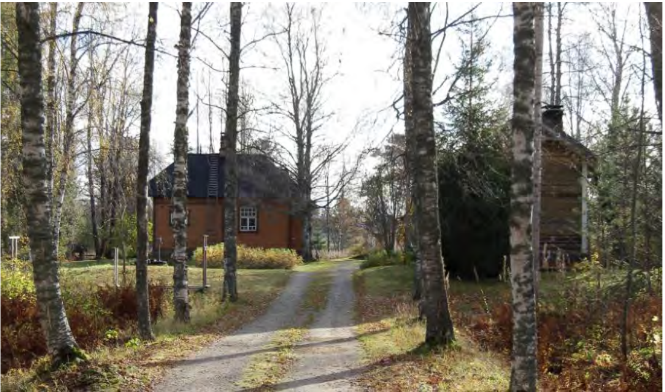
Kuva 14. Näkymä asemavartijan talolle Pysäkkitieltä. Oikealla hirsinen saunarakennus, jonka takaa häämöttää aitta.
