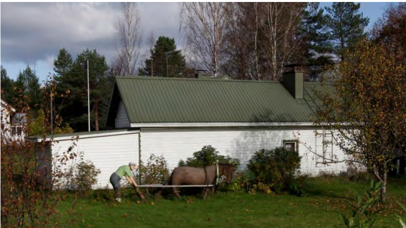
Kuva 63. Kylmäojantie 92. Talo on ilmeisesti 1950-luvulta, vaikka massoittelemuksen puolesta se muistuttaa enemmän 1930-luvun mökkejä. Tilalla on ollut lehmä. Taloa on remontoitu 1960-1970-luvuilla, mm. ikkunat on vaihdettu ja alkuperäinen hirsipinta on vuorattu mineriittilevyillä. Pihalla on hauskoja veistoksia kotieläimistä.
