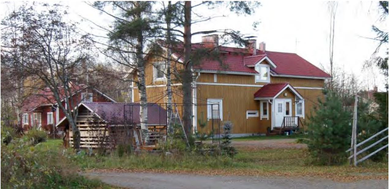
Kuva 51. Peltolantie 7b:ssä on toiminut 1970-luvulla posti. Tyypiltään rakennus on samanlainen kuin Kylmäojantien varren 1900-luvun alun rakennukset.
