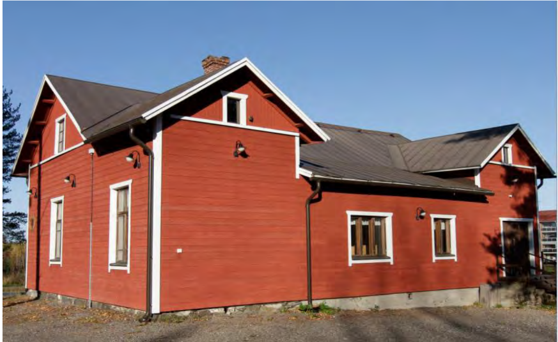
Kuva 5. Nuorisoseurantalons itäjulkisivu. etualalla näkyy alkuperäinen keittiösiipi. Sisäänkäynti on vuonna 1928 rakennetussa siivessä. Sisäänkäynti muutettiin kyseiselle paikalle vuoden 1938 muutostöiden yhteydessä. Laajennusosan perustus on betonia.
