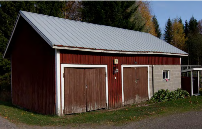
Kuva 60. Kylmäojankylätie 18. Mökki on suurin piirtein 1930-luvulta. Taloa on remontoitu ja laajennettu. Pihapiirissä on navetta 1950-luvulta.
