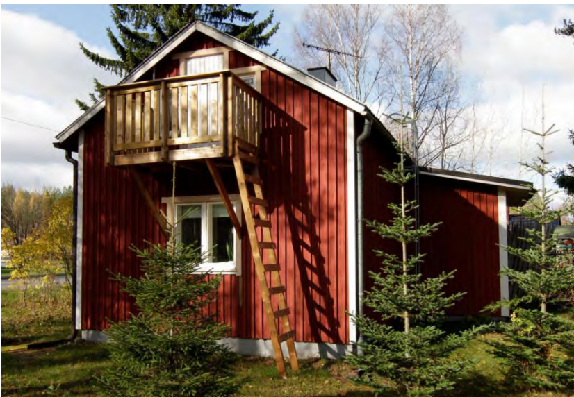
Kuva 62. Kylmäojantie 84 on pienehkö mökki 1950-luvun alusta. Rakennus on näkyvällä paikalla Kylmäojankylätien alussa. Kooltaan rakennus vastaa 1930-luvun mökkejä.
