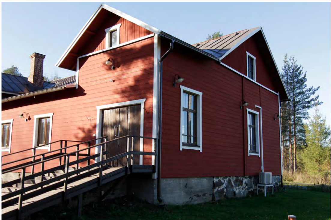
Kuva 6. Nuorisoseurantalons pohjoisjulkisivu ja sisäänkäynti. Alkuperäisen osan perustus on muurattu kivistä, laajennusosan valettu betonista. Ovi on 1980-luvulta.
