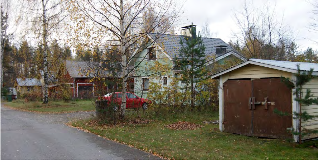
Kuva 42. Kanervakuja 12 ja 14. Kanervakuja 12:n ulkovuoraus on uusittu.
