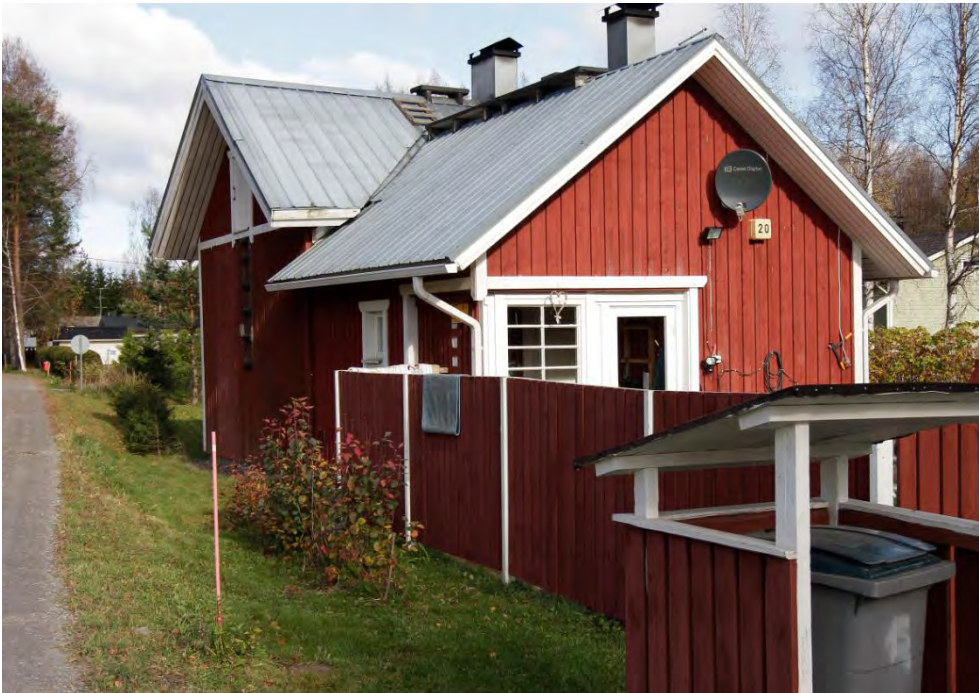
Kuva 57. Kylmäojan kylätie 20. Talo on ehkä 1920-luvulta. Ikkunat, ulkuvuoraus ja katto on uusittu. Mökkiä on myös luultavasti jossain vaiheessa laajennettu.
