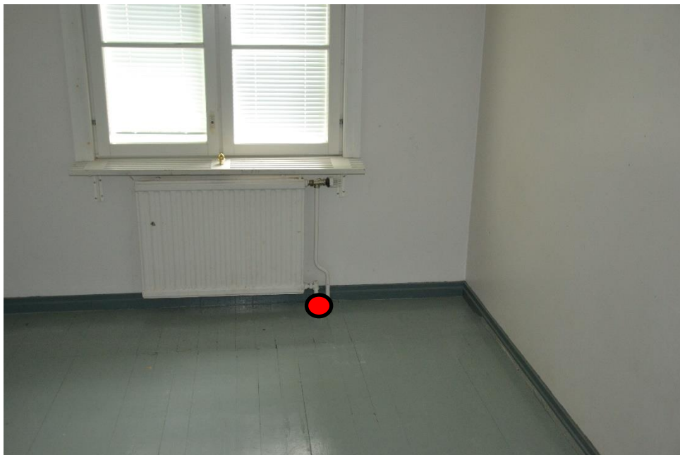
10.Salin viereinen makuuhuone: Lämpöputkien läpiviennin luokse.
