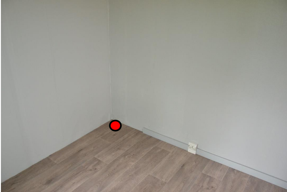
3.Takapihan kulmahuone: Muurin vastainen ristinurkka.
