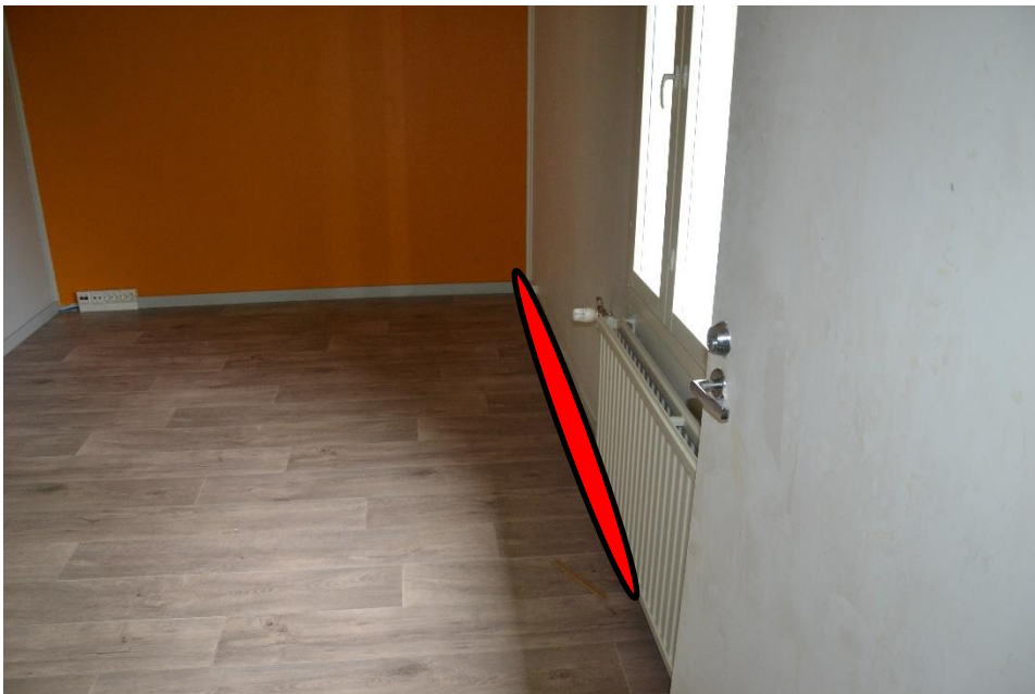
4.Takapihan kulmahuone: Ulkokulmauksen nurkasta ikkunan alapuolelle laajasti.
