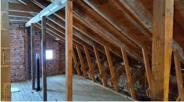
Kuva 22. Yleiskuva ullakkotilasta. Vesikatto on kannatettu puisten kattokannattajien avulla.
