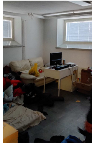
Kuva 37. Kellarin päädyssä on asuinhuone, johon on uusittu lattiapinnoitteeksi klinkkerilaatta.
