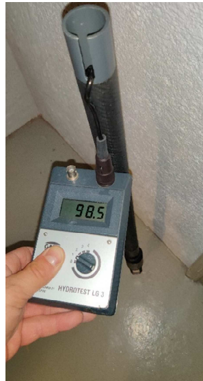
Kuva 31. Koholla olevaa pintakosteutta kantavien väliseinien sekä ulkoseinien vierustoilla. Havaintojen perusteella rakenteisiin pääsee nousemaan kosteutta maaperästä.
