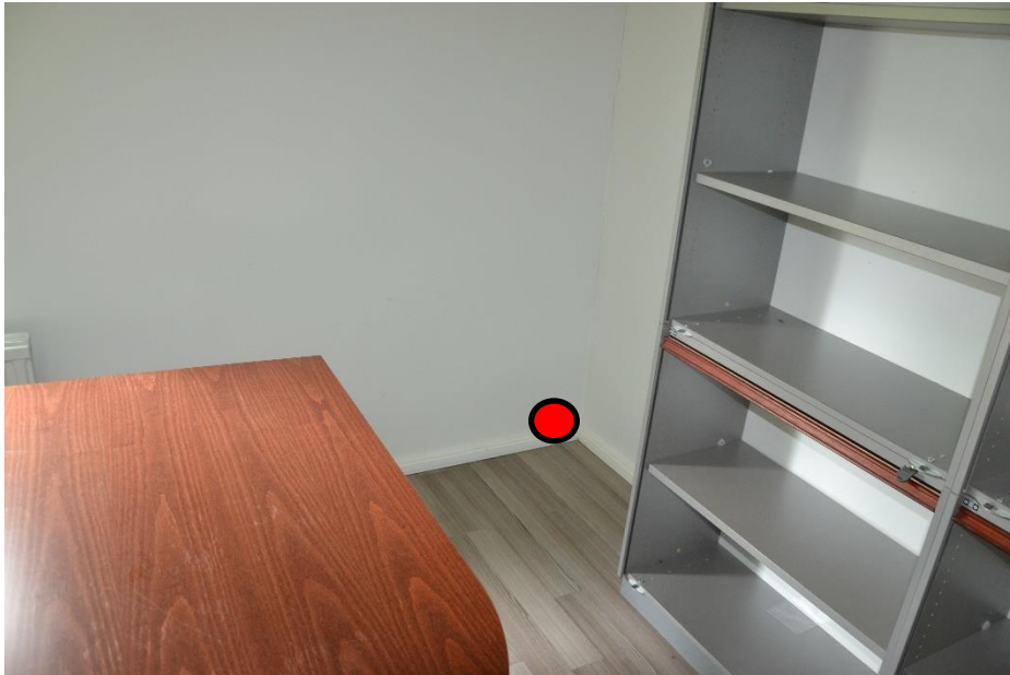
9.Toimisto, keittiön viereinen huone: Ikkunan oikealle puolelle ulkoseinän ja lattian raja.
