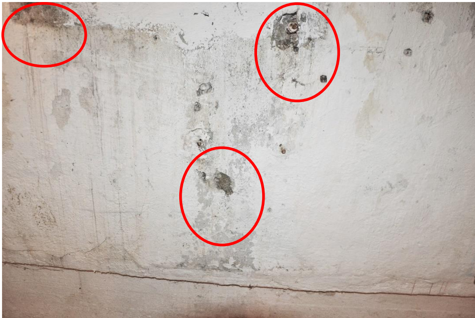
Esimerkkikuva perusmuuriseinässä olevasta tojalevy-eristeestä.
