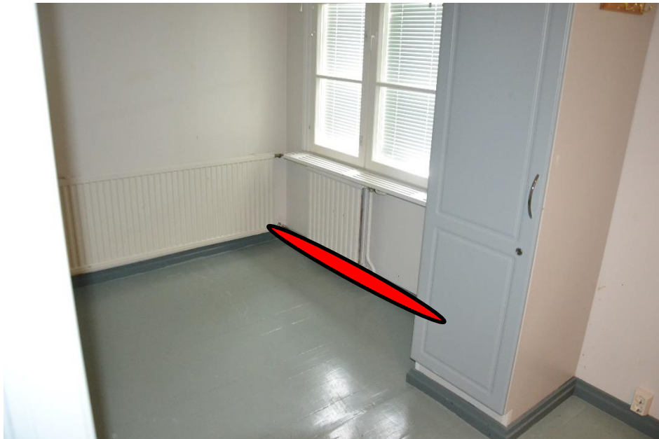
8.Aulan makuuhuone: Pienemmän osan ikkunaseinää laajalti.
