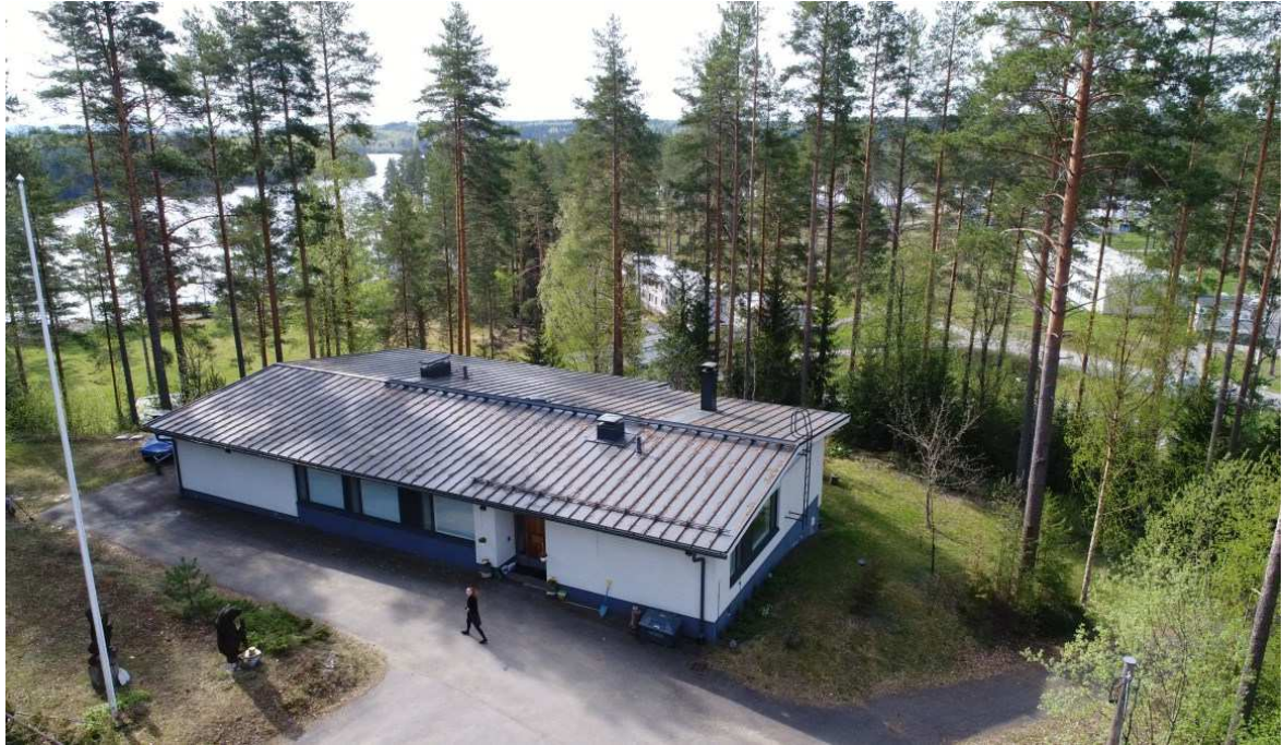
Pyörteenvaaran rinnesijaintinsa myötä asuinrakennuksesta avautuu näkymä niin Pielisjoen kuin sairaalan suuntaan. Tämä drone-kuva on kuvattu 16.5.2023, kuten muutkin valokuvat. Drone-kuvien kuvaaja on ____, muiden Johanna Kettunen
