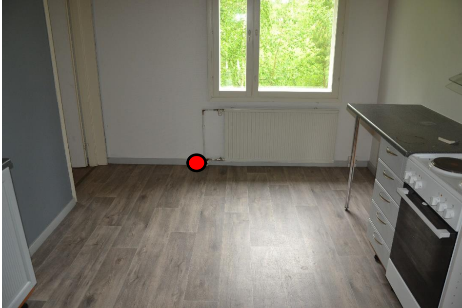
5.Keittiö: Ikkunan vasempaan reunaan putkiläpiviennin luokse.
