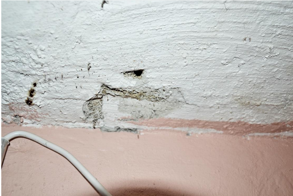
Esimerkki kellarikerroksen katossa olevasta tojalevy-eristeestä.
