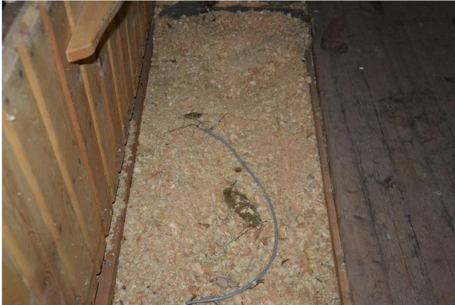
Yläpohjan purueristettä ullakkotiloista havainnoituna.
