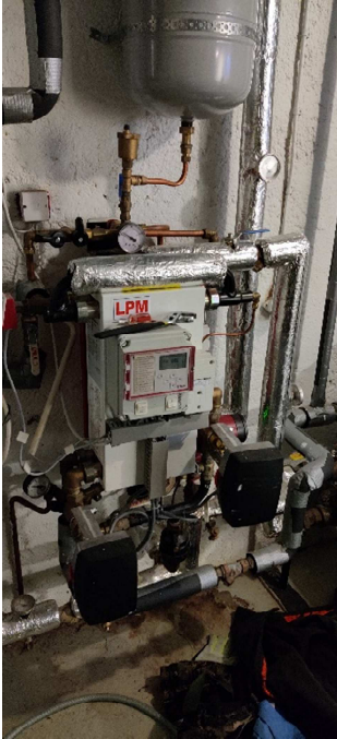
Kuva 32. Kohde liitetty alueen kaukolämpöön, jonka yhteydessä lämmönsiirrin on asennettu.
