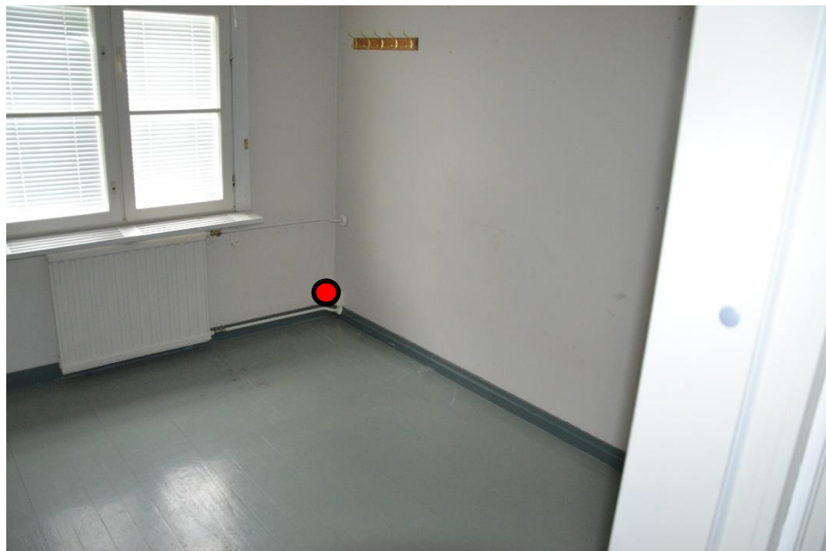
2.Keskimmäinen makuuhuone: Ulkoseinän ja takapihan makuuhuoneen välisen seinän nurkkaus.
