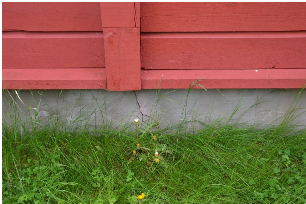
Esimerkkikuva sokkelin murtumasta.
