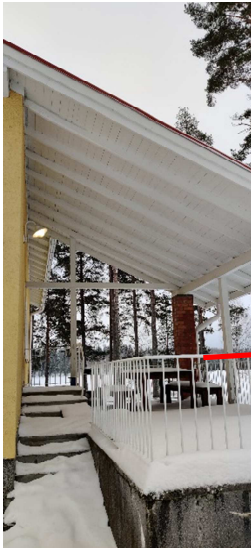
Kuva 10. Terrassit ovat betonirakenteisia ja katettuja. Kattolape jatkuu yhtenäisenä terassille.
