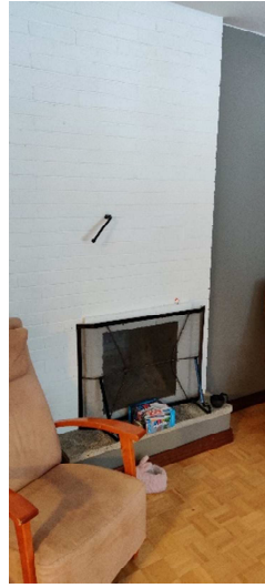
Kuva 41. Kohteessa alkuperäinen paikallaan muurattu takka. Takka on varustettu kesäpellillä. Takan kuntoa ei tarkastettu.
