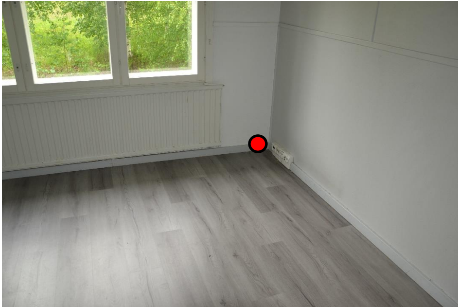
7.Olohuone: Ikkunan oikeanpuoleinen ulkoseinän nurkkaus.
