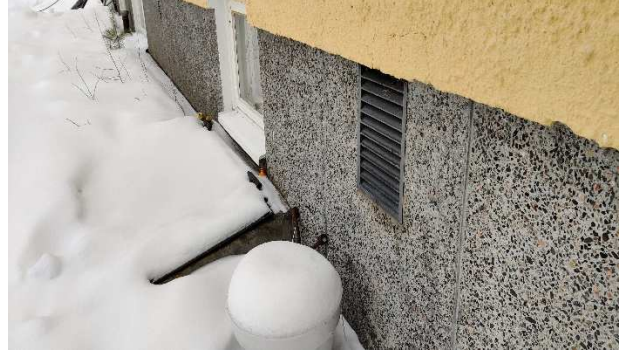
Kuva 9. Kellarin korvausilmäräppänät tulevat sokkelin läpi.
