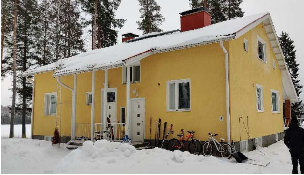
Kuva 2. Yleiskuva kohteesta etupihan puolelta. Julkisivut peruskuntoiset.
