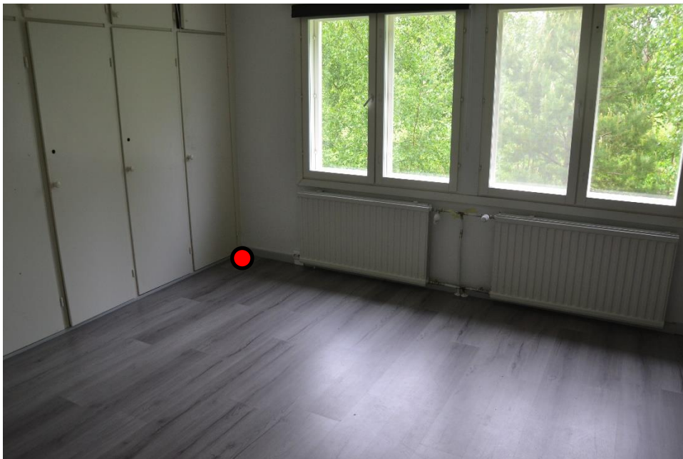
6.Olohuone: Kaapiston ja ulkoseinän nurkkaus.
