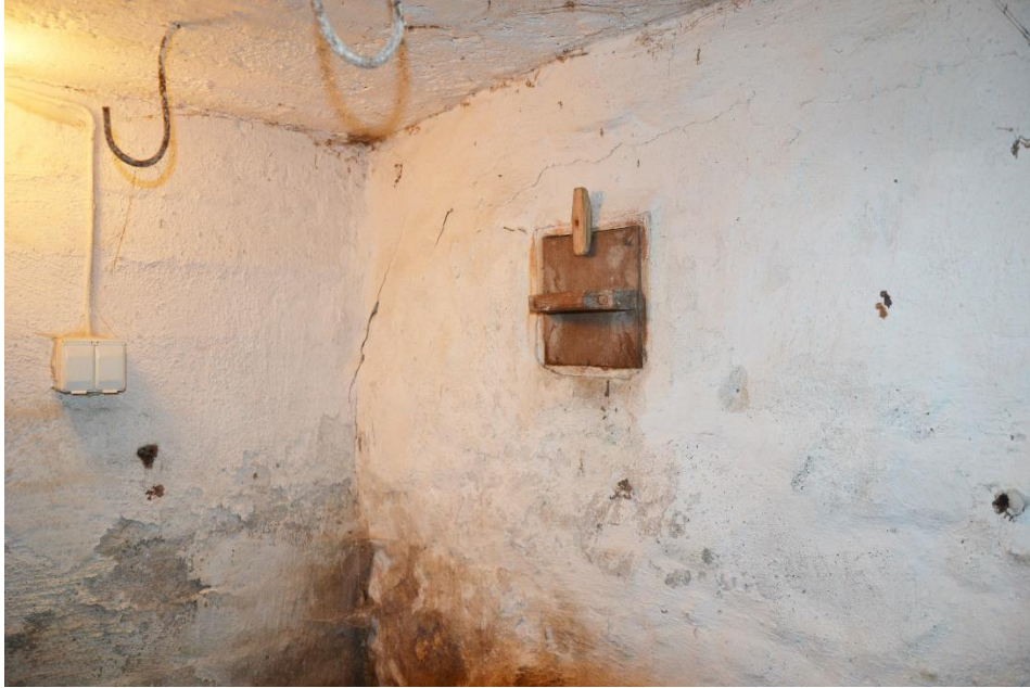
Esimerkkikuva suljetusta ilmanvaihtoluukusta keittiön alapuolisesta osakellarista.
