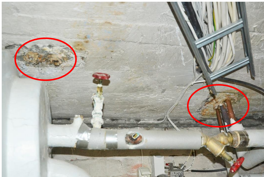
Esimerkkikuva teknisestä tilasta asuinkerrokseen nousevista epätiiviestä läpiviennistä.
