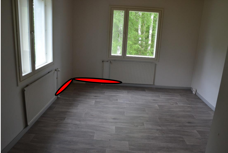
1. Etupihan kulmamakuuhuone: Ulkokulmauksen luota laajalti.
