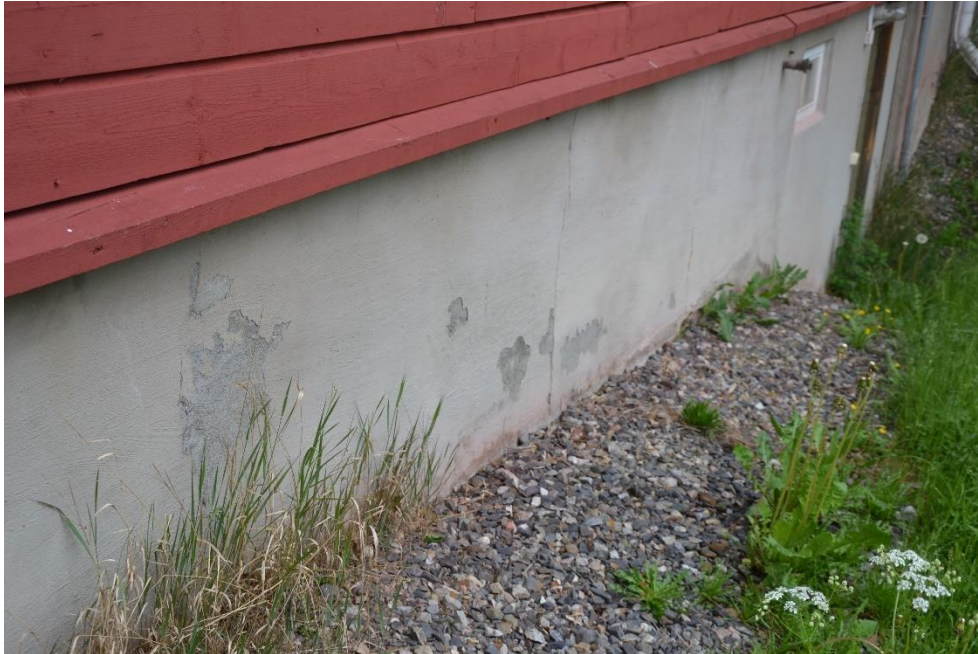
Esimerkkikuva sokkelin murtumasta ja pinnan hilseilystä.
