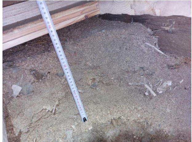
Kuva 65. Lämmöneristettä noin 30 cm.
