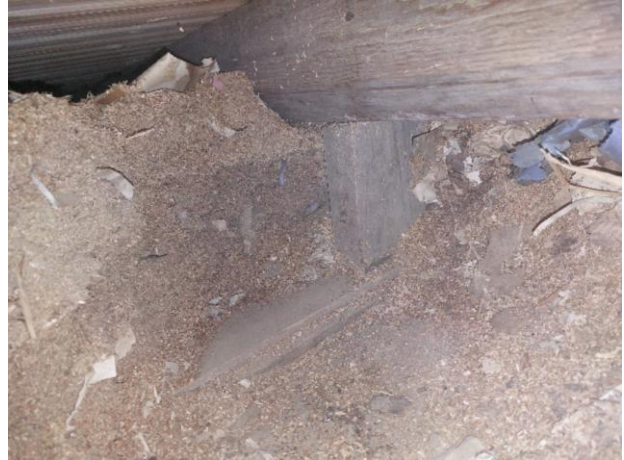
Kuva 69. Eristekerroksen alaosissa on aistittavissa vaurioon viittaavaa hajua.
