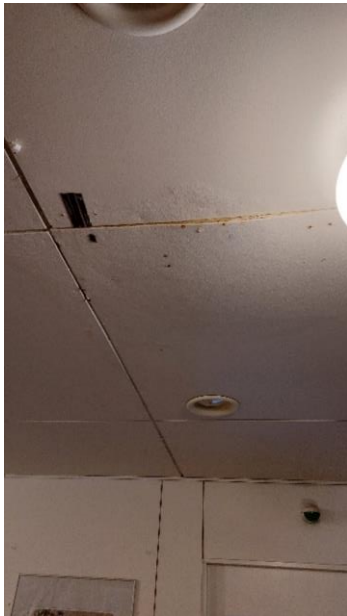
Kuva 56. Vettä on vuotanut runsaasti laajennusosan katosta sisätiloihin.
