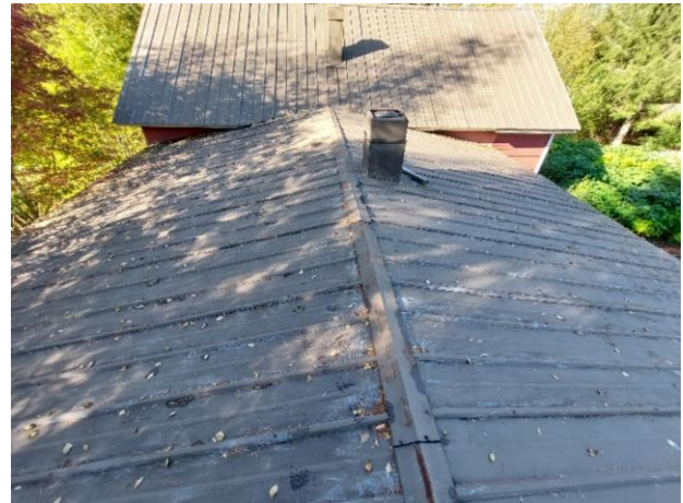
Kuva 33. Vesikatto on peräisin 1970-luvulta.
