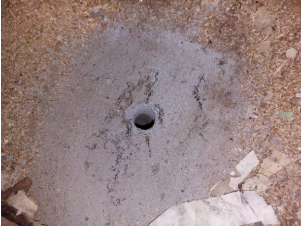
Kuva 68. Laatan alapuolella on täyttömaata.
