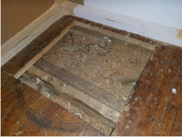
Kuva 62. Alapohjaan tehtiin rakenneavaus.
