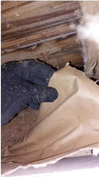
Kuva 16. Ulkoseinän ilmansulkuna on käytetty muovilla pinnoitettua rakennuspaperia.
