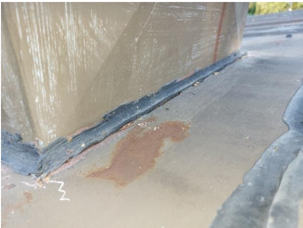
Kuva 38. Läpiviennit silmämääräisesti epätiivit.
