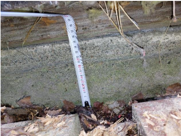
Kuva 32. Maanpinnan korko seinien alaosaan alle 15 cm takaseinustalla.
