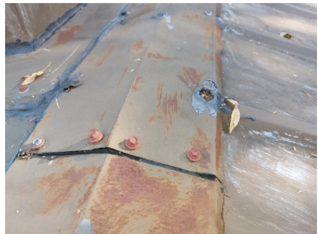
Kuva 35. Jiirit ruostuneet, kiinnikkeet irronneet.
