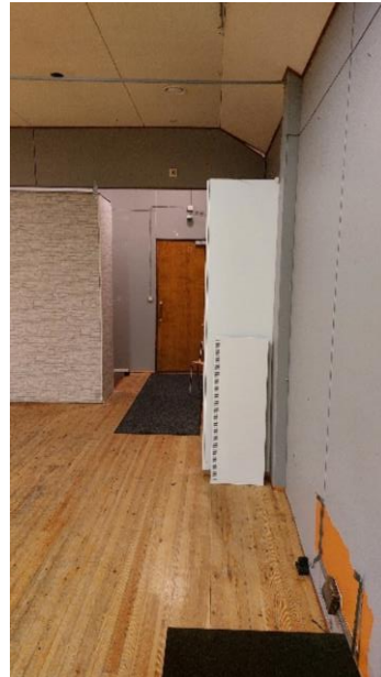
Kuva 61. Yleisnäkömää vanhasta rakennusosasta.
