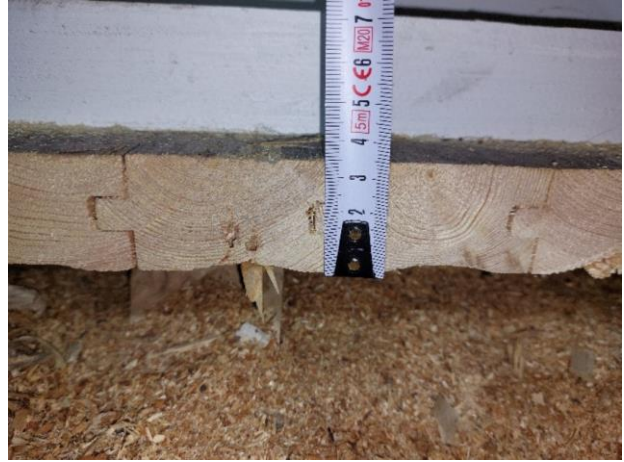
Kuva 63. Lankkulattian alla pieni ilmarako.
