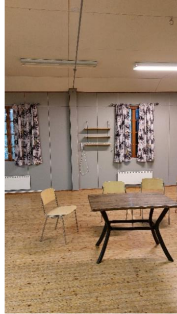
Kuva 59. Följareille on tehty kotelorakenteet.
