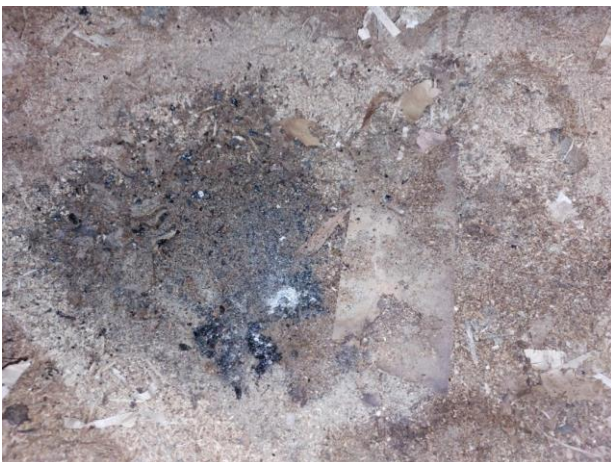
Kuva 66. Roskavalun päällä pikisivelykerros.
