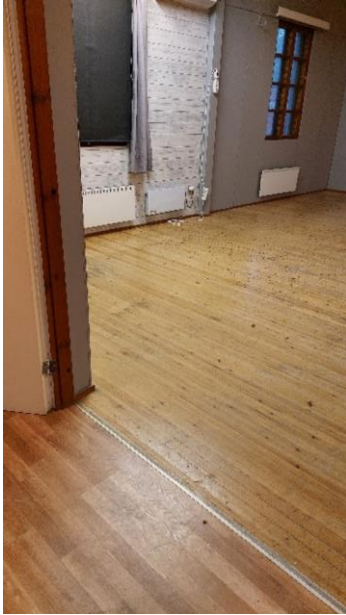
Kuva 58. Alkuperäisellä rakennusosalla parketti.
