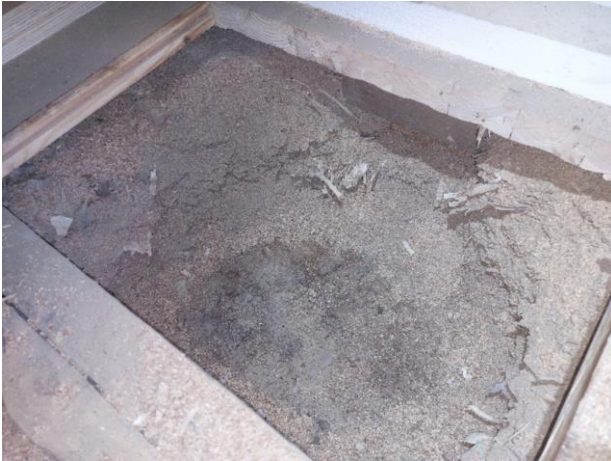
Kuva 64. Alapohja on purueristeinen.
