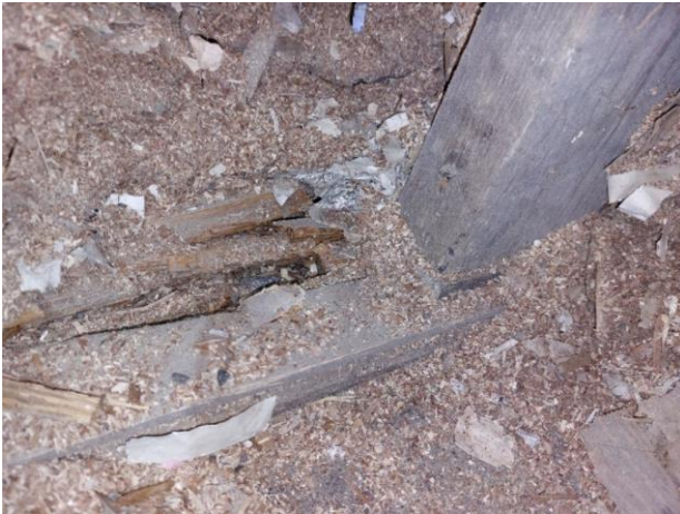
Kuva 70. Eristeet ovat kostuneet alaosistaan. Pui- sissa koolausrakenteissa on havaittavissa paikallisia la- hovaurioita.
