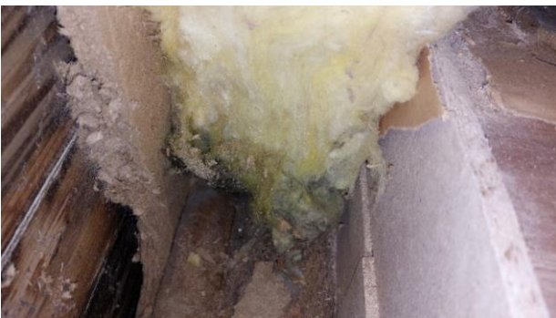
Kuva 16. Ulkoseinän ilmansulkuna on käytetty muovilla pinnoitettua rakennuspaperia.
