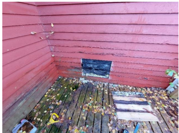
Kuva 19. Alkuperäistä rakennusosaa tarkasteltiin kahden ulkopuolelle tehdyn rakenneavauksen kautta.
