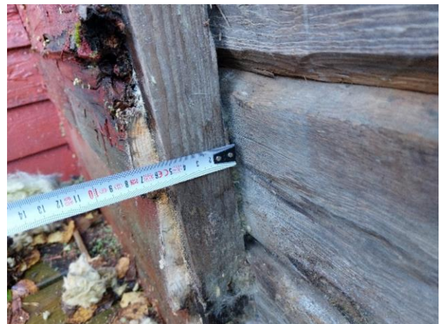
Kuva 25. 5 cm paksu lisäkoolaus asennettu suoraan kiinni hirsiseinään.
