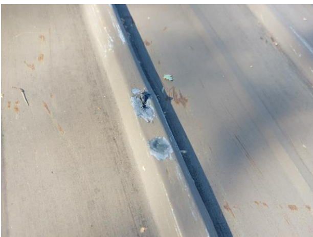
Kuva 38. Läpiviennit silmämääräisesti epätiivit.
