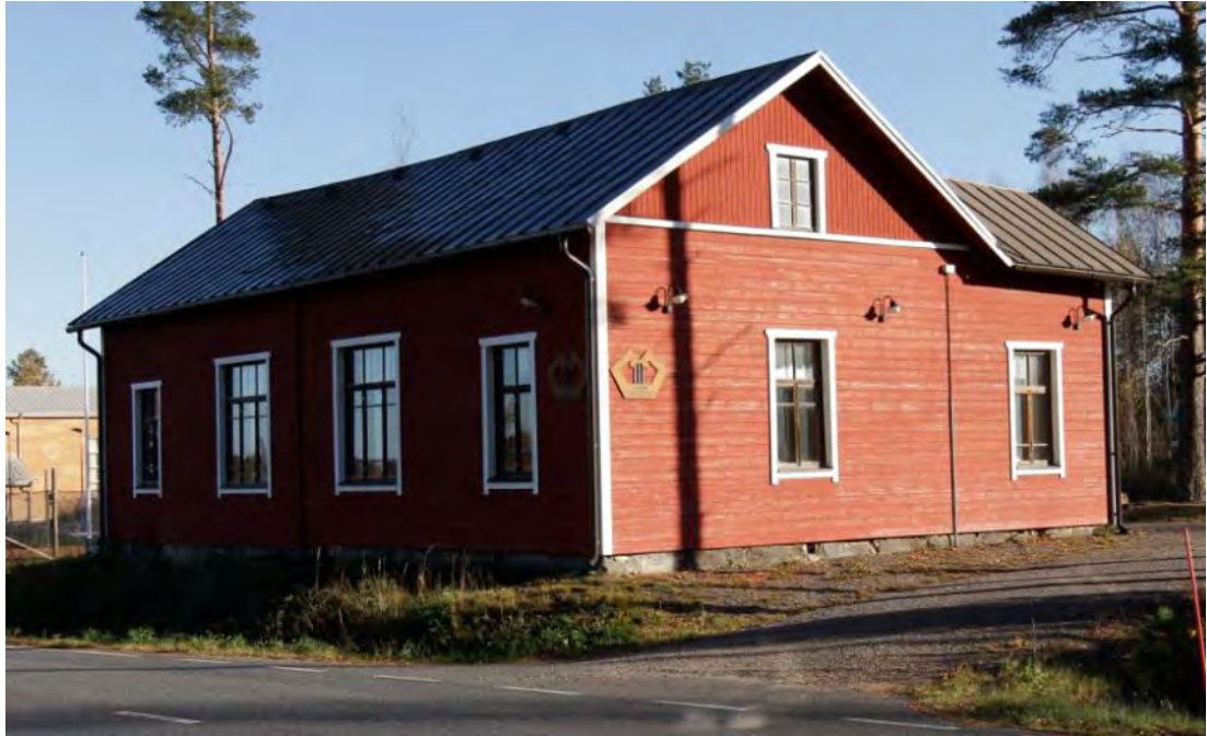
Kuva 3. Nuorisoseurantalons Kylmäojantien puoleinen julkisivu ja eteläpääty.
