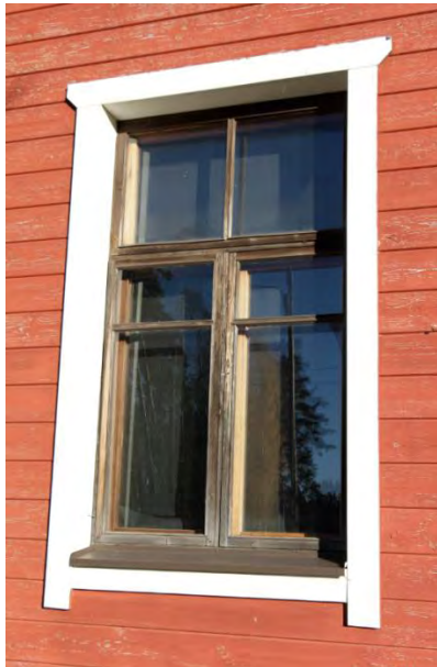
Kuva 4. Ikkunat on uusittu 1980-luvulla.
