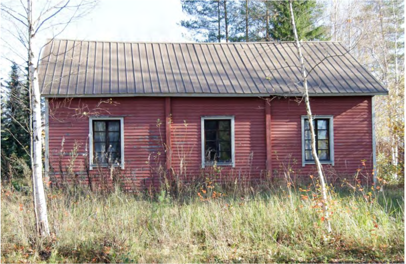
Kuva 17. Lehmon työväenyhdistyksen itäjulkisivu.
