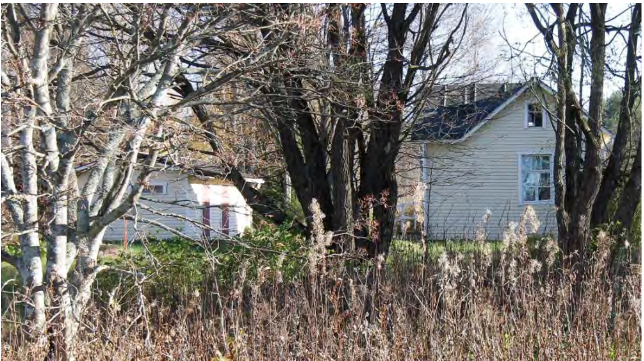
Kuva 10. Lepolan mökin länsijulkisivu ja piharakennus.
