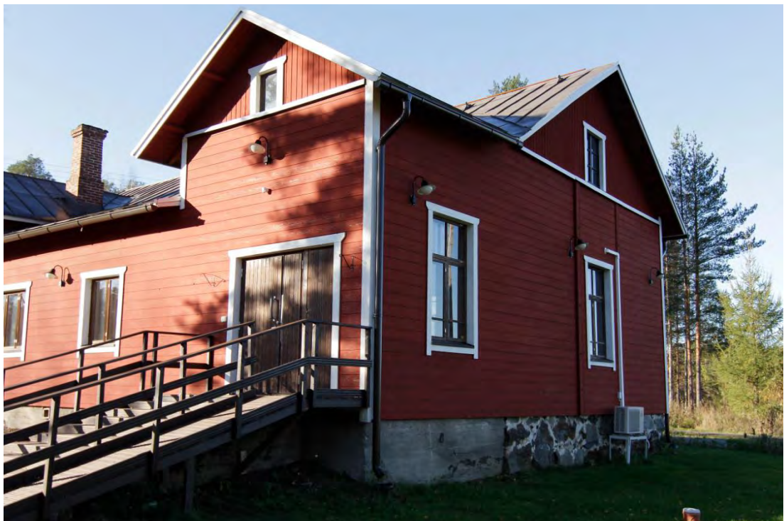
Kuva 6. Nuorisoseurantalons pohjoisjulkisivu ja sisäänkäynti. Alkuperäisen osan perustus on muurattu kivistä, laajennusosan valettu betonista. Ovi on 1980-luvulta.
