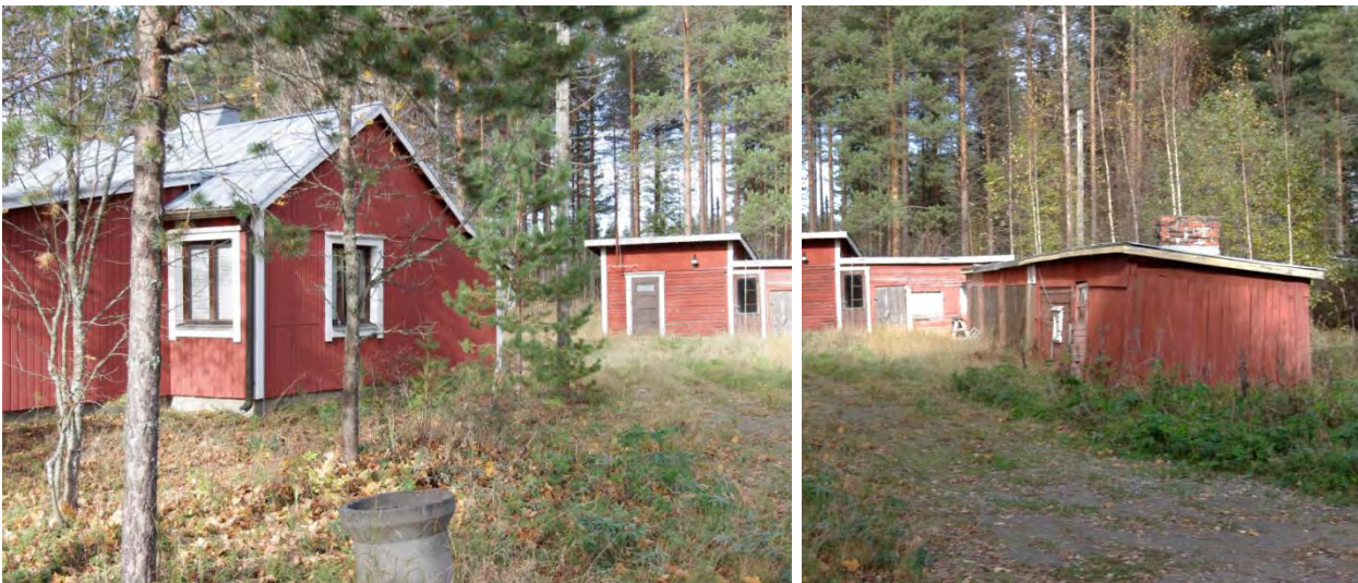
Kuva 53. Keksikuja 5. Tontti on lohkottu Autiolan tilasta vasta 1970-80-luvuilla. Rakennuspaikka on vanhempi. Päärakennus on noin vuodelta 1945. Sitä on myöhemmin laajennettu. Tontilla on ilmeisesti ollut kauppa 1970-luvun alussa.
