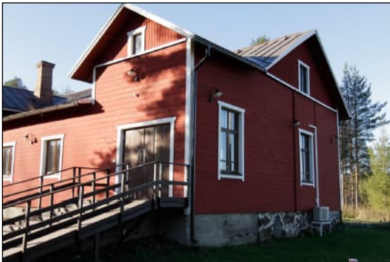
Kuva 21. Nuorisoseurantalons pohjoisjulkisivu ja sisäänkäynti.
