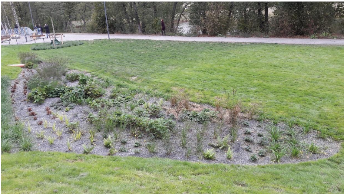
Kuva 13. Esimerkki hulevesien biosuodatuskentästä kerrostaloalueella Tukholmassa. Kenttä on toteutettu pilaantuneelle maaperälle eristämällä rakente ympäröivästä maaperästä bentoniittimatolla. Vedet johdetaan rakenteen pinnalle tulevalla purkuputkella puhdistumaan.
