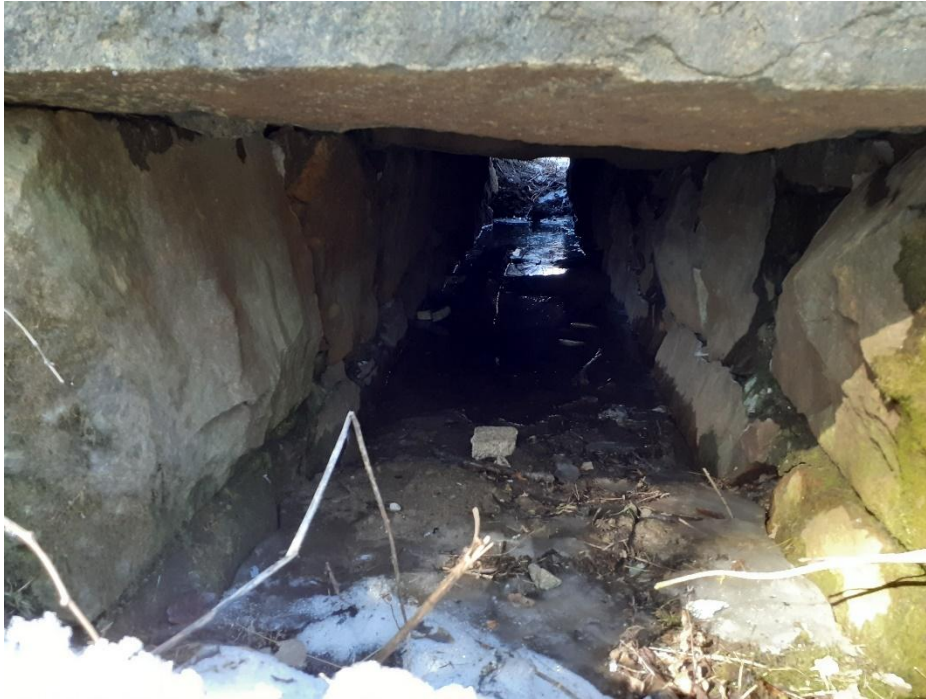
Kuva 10. Toinen radan alittavista silta-aukoista.
