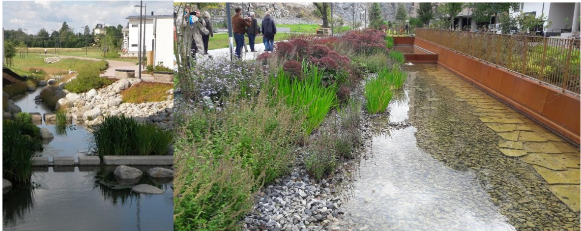
Kuva 16. Hulevesien johtamiseen ja virtaaman viivyttämiseen tarkoitettuja avouomia pohjoismaisissa kaupungeissa.
