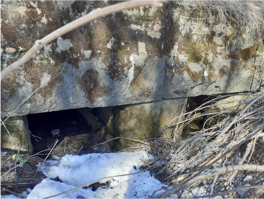
Kuva 9. Radan alittavan rummun viereiset silta-aukot.
