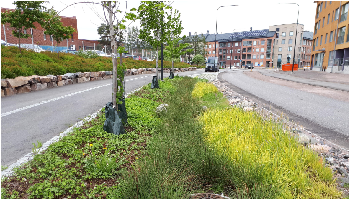
Kuva 14. Toteutunut biosuodatusalue kadun verralla Helsingin Kuninkaantammessa.
