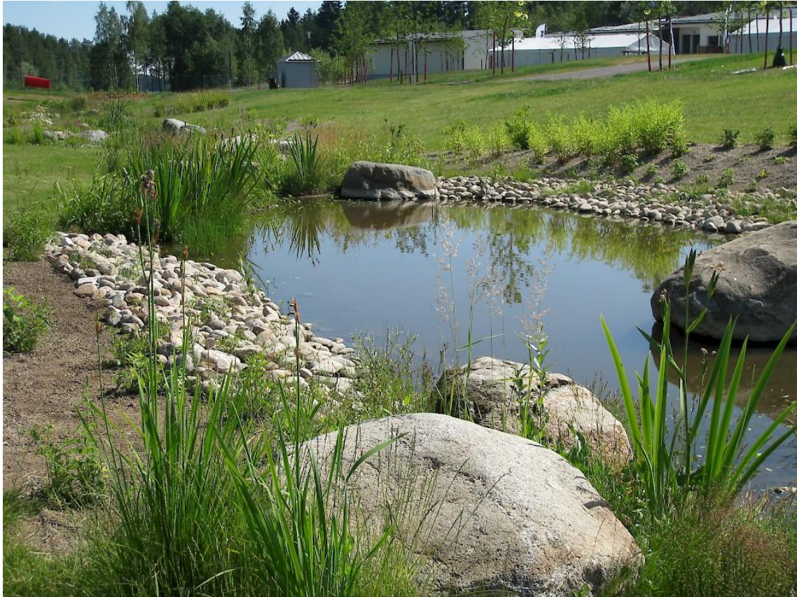
Kuva 17. Esimerkki huleveden tasausaltaasta Kuopion asuntomessualueella. © Viherympäristöliitto.
