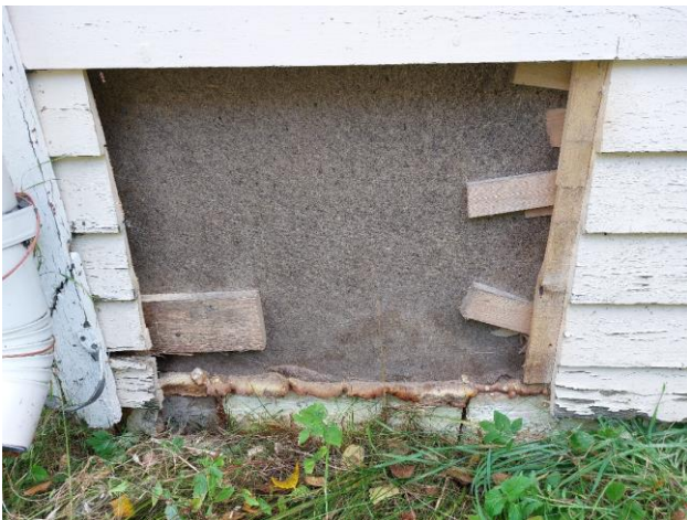
Kuva 2. Ulkoseinän avauspiste US-RT1 tehtiin päätyseinälle, keittiön ja wc:n puolelle.
