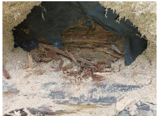
Kuva 7. Seinän alaosissa todettiin laajoja laho- vaurioita.
