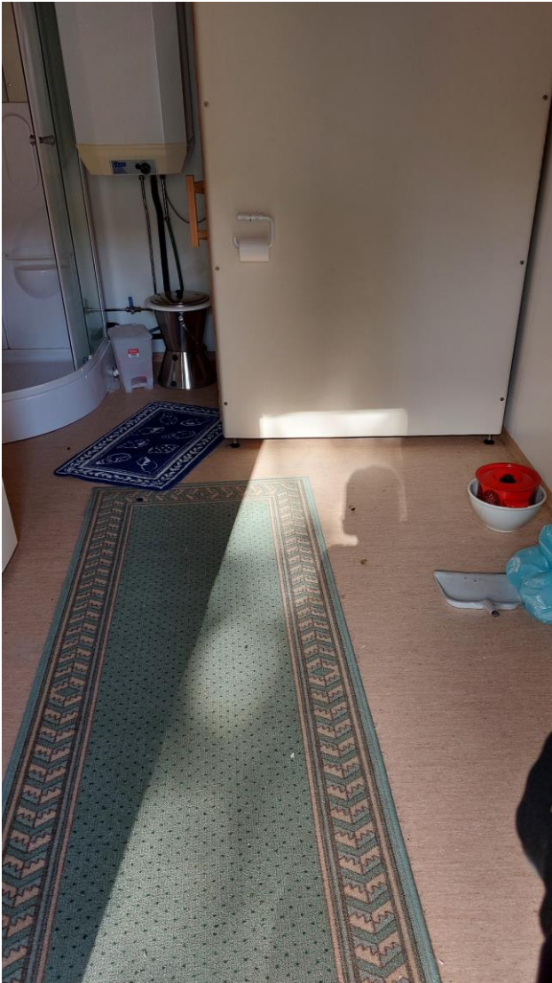
Kuva 26. Varastorakennuksessa suihkutilat. Lattiapinnoitteena muovimatto.
