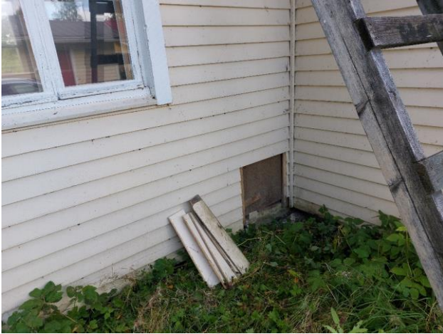
Kuva 11. Ulkoseinän rakenneavauspiste RT2 tehty etupihan puolelle.
