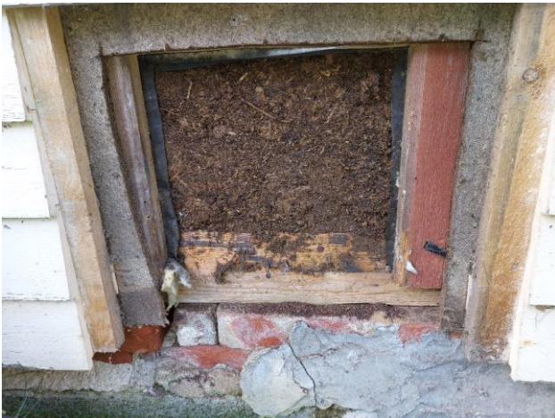
Kuva 24. Päätyseinällä purueristysten sijasta muhaeristys.
