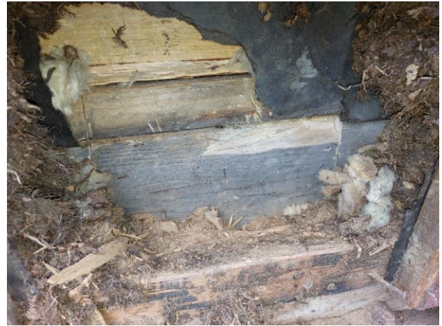
Kuva 27. Avauksessa oli näkyvissä alapohjan puurakenteita.
