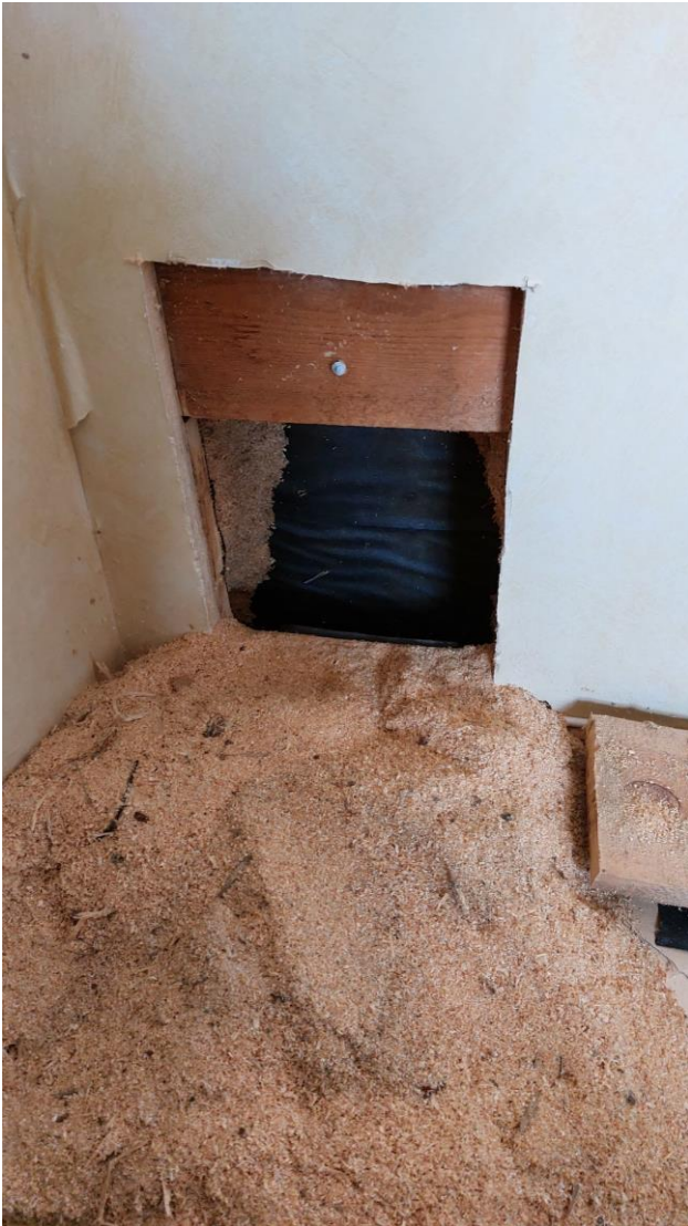
Kuva 18. Ulkoseinän rakenneavauspiste RT3 tehtiin sisäkautta takapihan puolelle.
