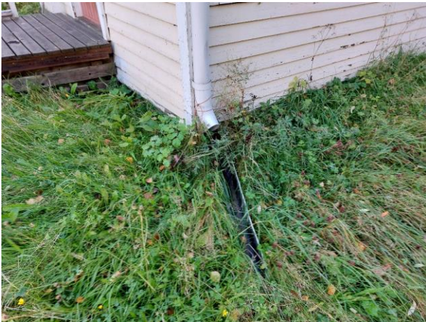
Kuva 4. Maanpinnan muodot tasaiset. Syöksytorien jatkoksi asennettu jatkokourut.
