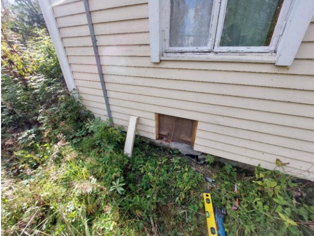
Kuva 22. Ulkoseinän rakenneavauspiste RT4 tehtiin makuuhuoneen puoleiselle päätyseinustalle
