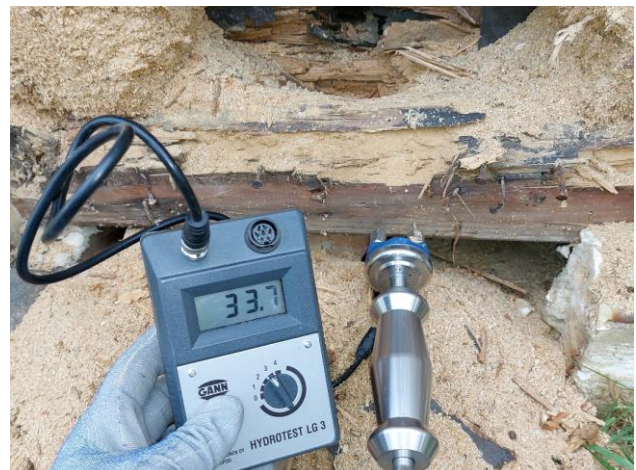
Kuva 7. Seinän alaosissa todettiin laajoja laho- vaurioita.
