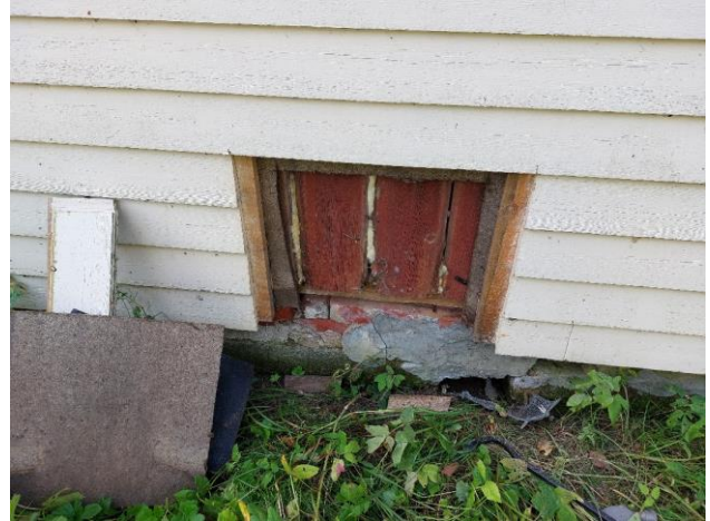
Kuva 23. Uusitun julkisivun takana vanha pysty-laudoitus/julkisivu.
