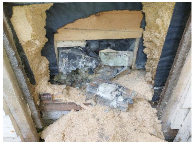
Kuva 14. Seinän alaosan eristeet kastuneet. Alaohjauspuussa lahoa ja purueristeen ulkopinnassa rihmastokasvustoa.
