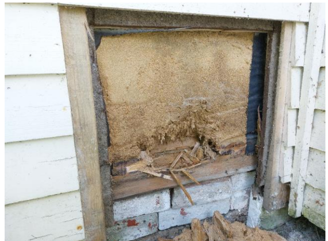
Kuva 14. Seinän alaosan eristeet kastuneet. Alaohjauspuussa lahoa ja purueristeen ulkopinnassa rihmastokasvustoa.
