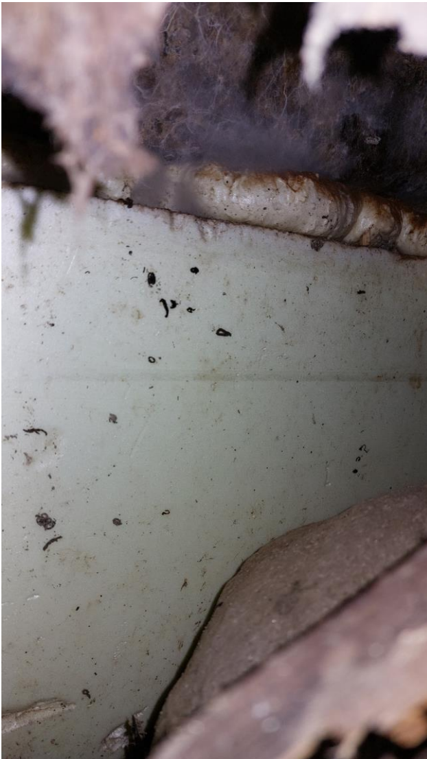
Kuva 28. Alapohjan puurakenteissa todettiin selkeitä lahovaurioita.
