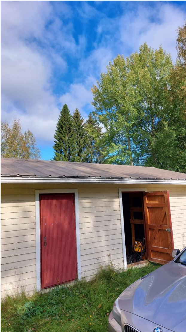
Kuva 28. Varastorakennus on peräisin 1950-luvulta.
