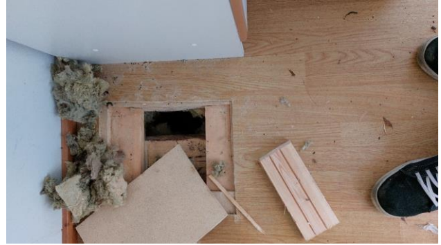
Kuva 29. Alapohjaa on uusittu. Kannatinrakenteiden päällä uudet lattialastulevyt, ponttilaudotus ja muovimatto.
