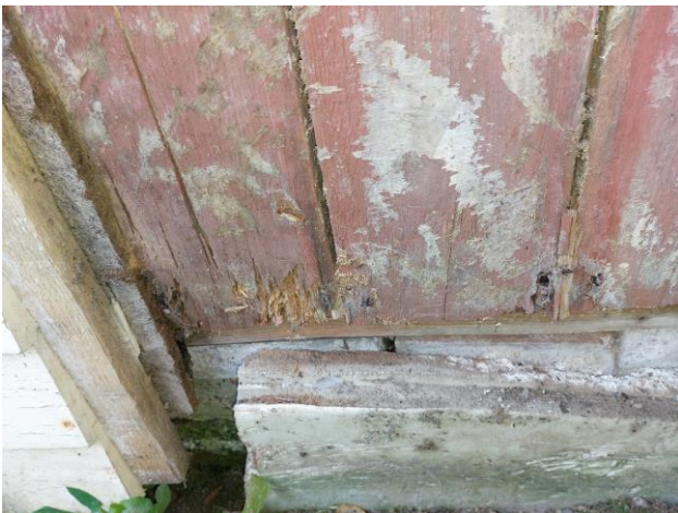
Kuva 13. Vanhan julkisivun alaosissa näkyvissä lahovaurioita.
