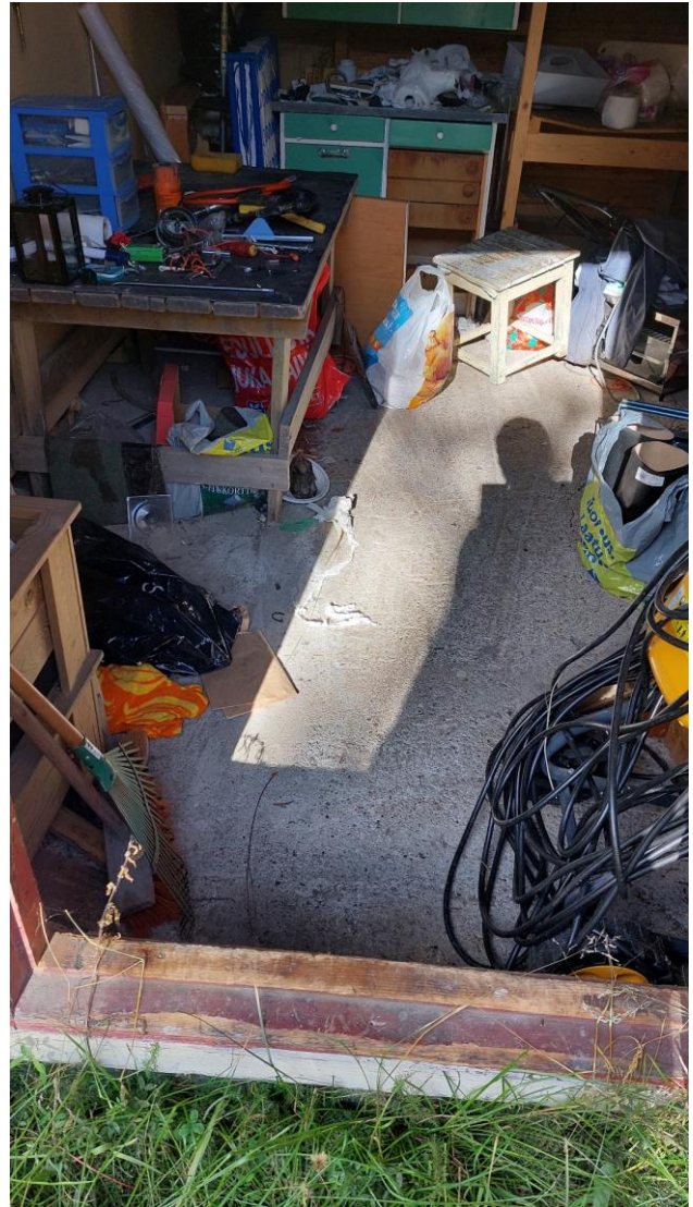
Kuva 29. Varaston puolella betonilattia.
