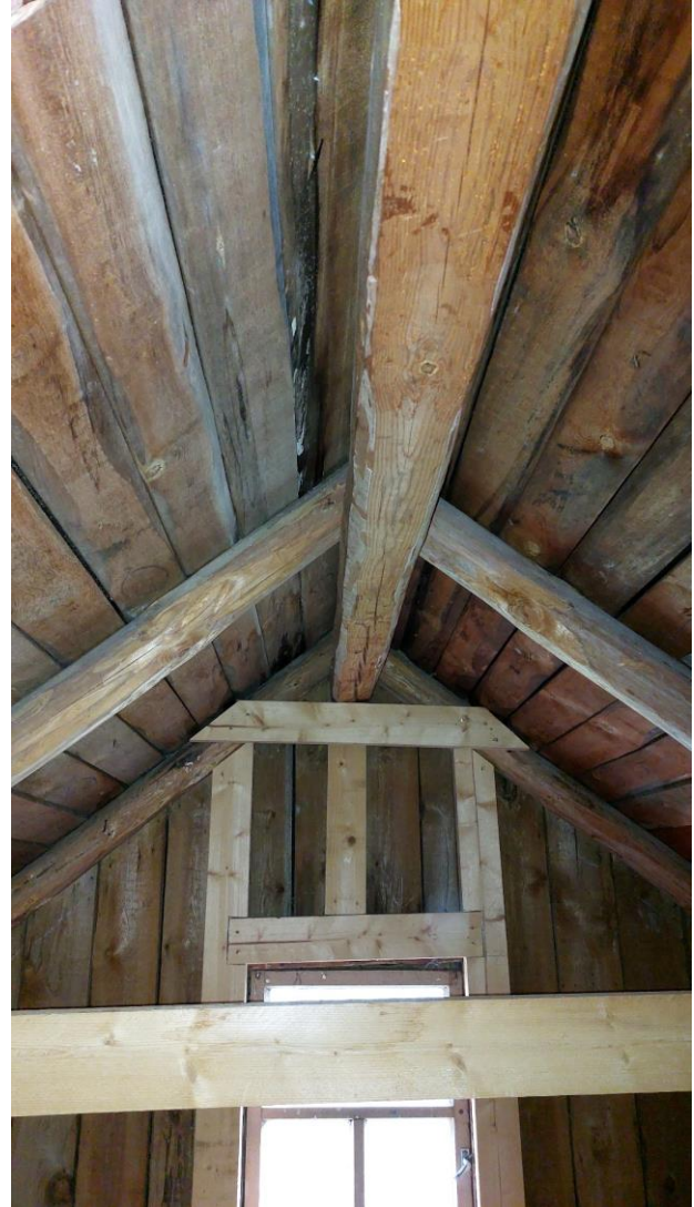
Kuva 20. Osa yläpohjan puurakenteista on uusittu.
