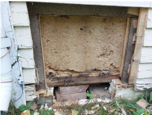
Kuva 6. Perustukset ovat osin tiilirakenteiset.
