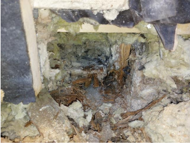
Kuva 17. Lahonnutta ulkoseinän alaosan puurakenteita sekä alapohjan rakenteita.
