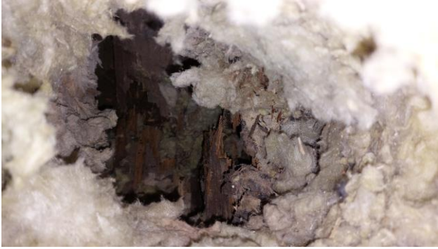
Kuva 28. Alapohjan puurakenteissa todettiin selkeitä lahovaurioita.
