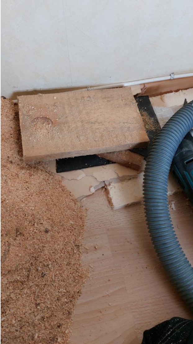
Kuva 20. Purueristeessä aistittavissa mikrobiperäistä hajua.
