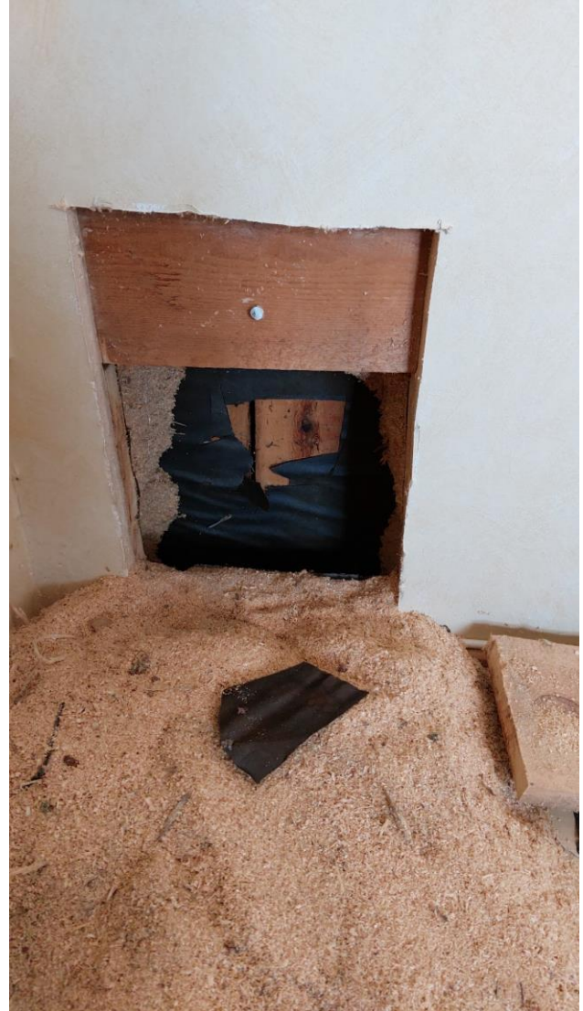
Kuva 21. Purueristeestä otetussa materiaalinäytteessä todettiin selvää mikrobikasvustoa.
