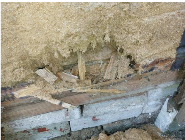
Kuva 13. Vanhan julkisivun alaosissa näkyvissä lahovaurioita.
