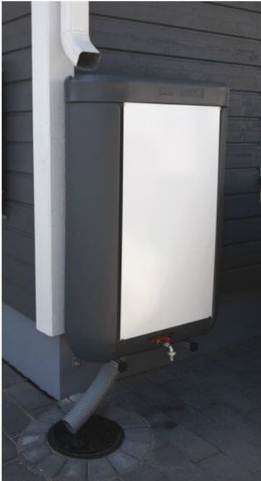
Kuva 10. Kattovesien kerääminen säiliöön (Kuva: Rakentaja.fi).
