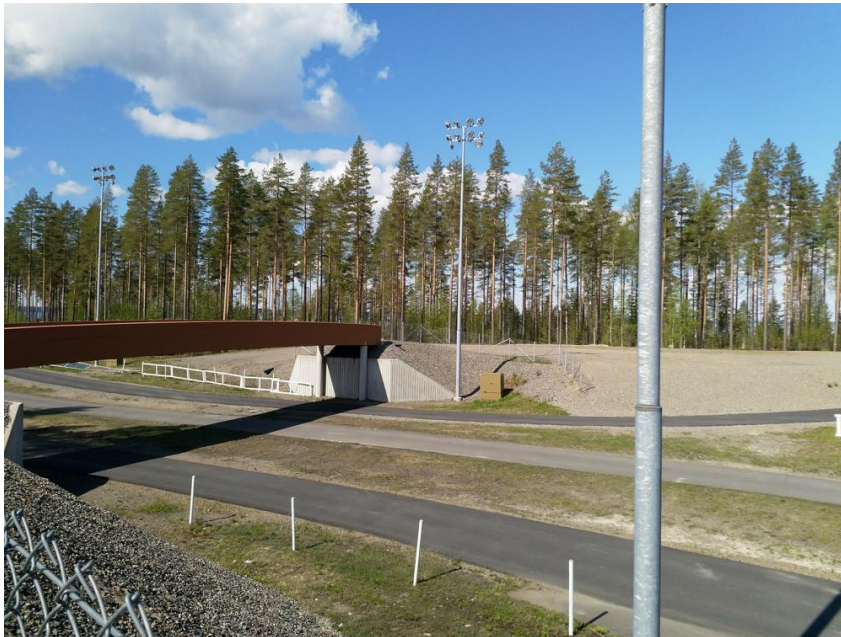
Kuva 23. Alueen rakennettua ympäristöä (FCG 2020)
