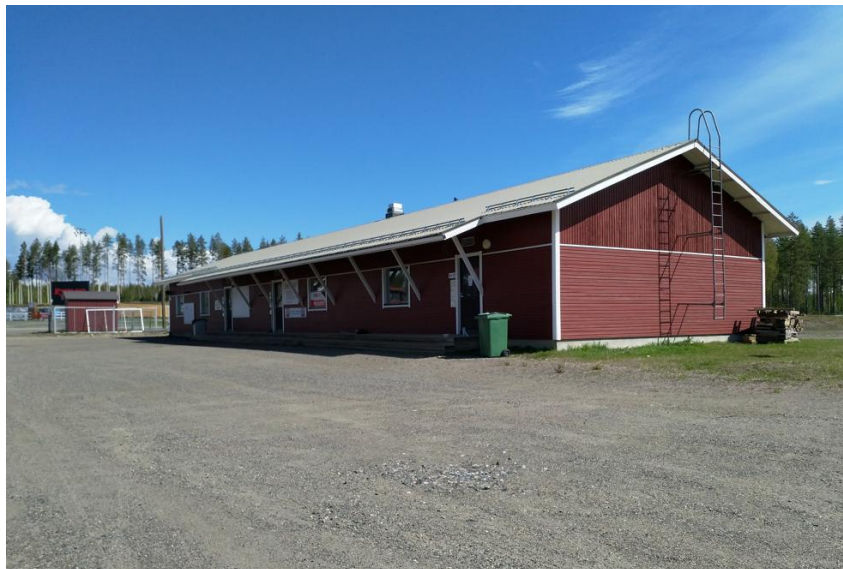
Kuva 19. Alueen rakennuskantaa. (FCG 2020)
