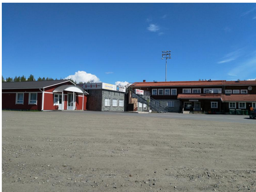
Kuva 20. Alueen rakennuskantaa, stadionrakennuksia. (FCG 2020)
