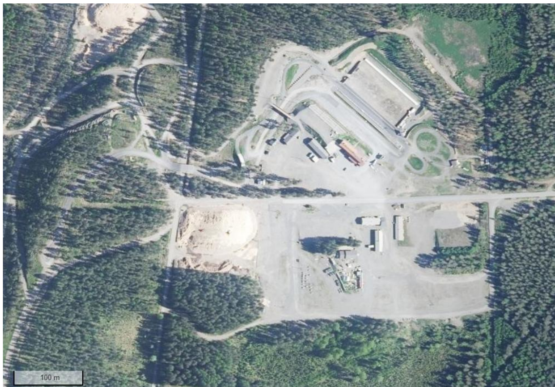
Kuva 16. Ilmakuva alueen keskeisistä toiminnoista ja rakennuksista. (MML)
