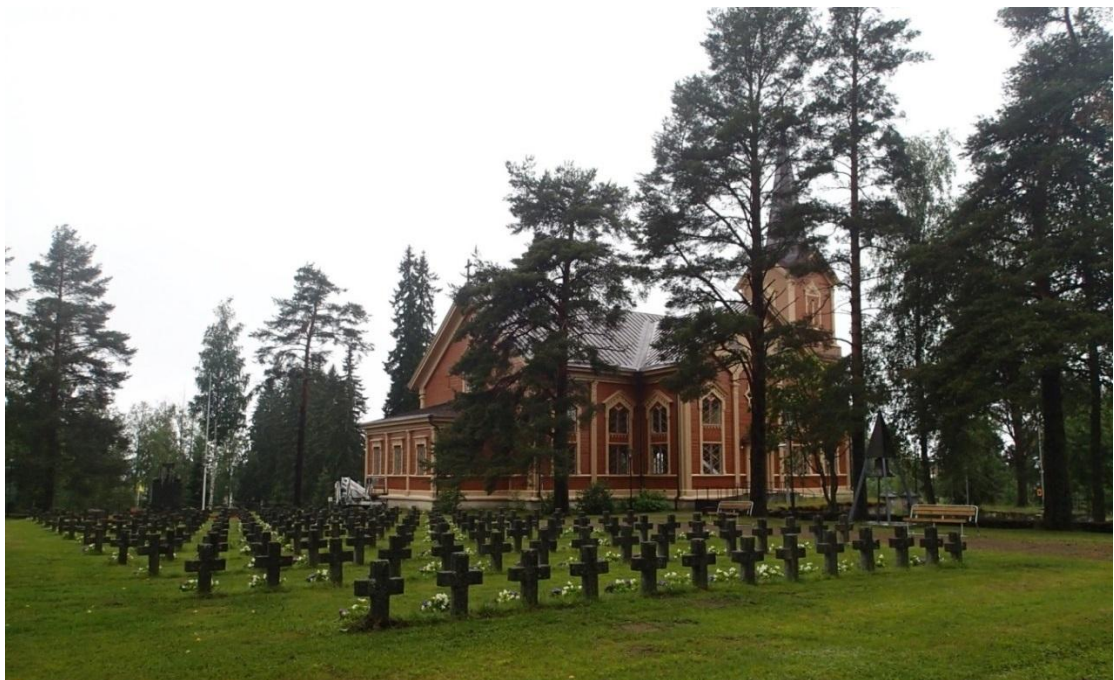
Kuva 31. Kontiolahden kirkko on rakennussuojelukohde (sr-1).
