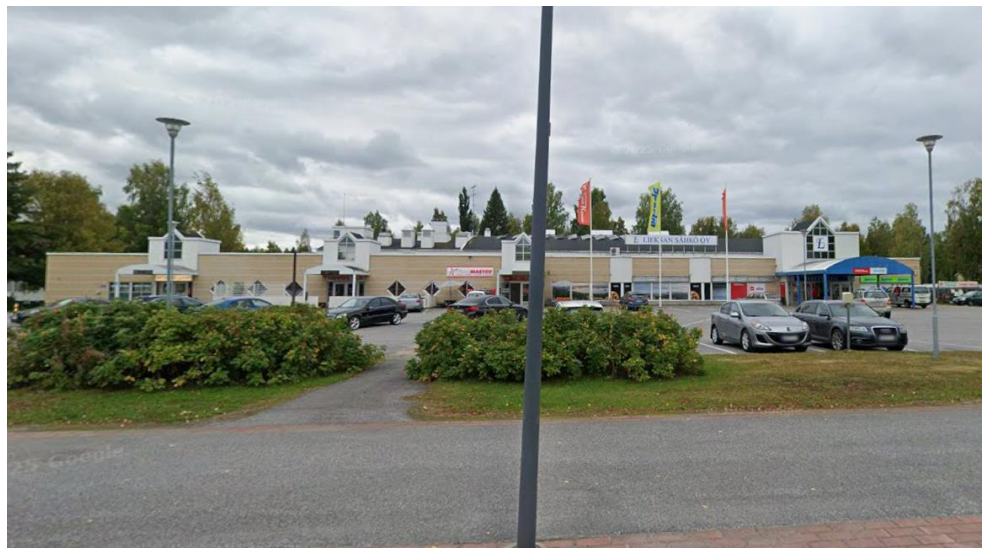
Kuva 5. Pielisentie 10-12. Vuonna 1990 valmistunut liikerakennus. (© Google Maps).
