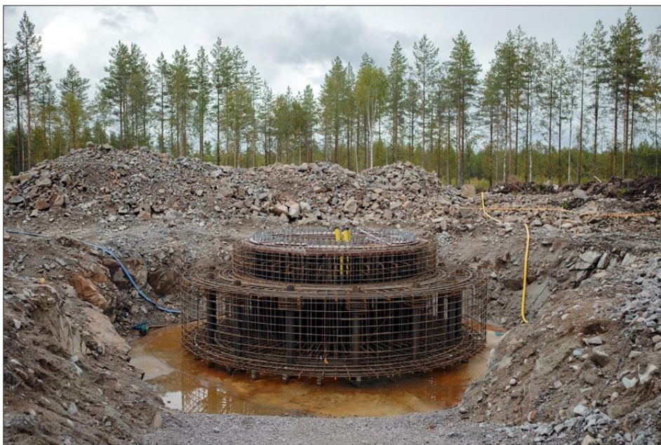
Kuva 6-3. Maanvarainen teräsbetoniperustus raudoitettuna ennen betonivalua.
