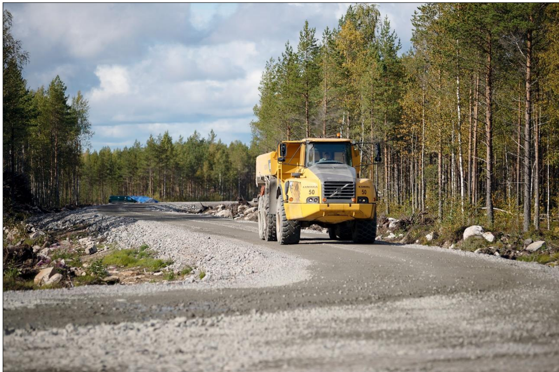
Kuva 6-7. Esimerkkikuva tuulipuiston rakenteilla olevasta huoltotiestä (kuva: OX2).
