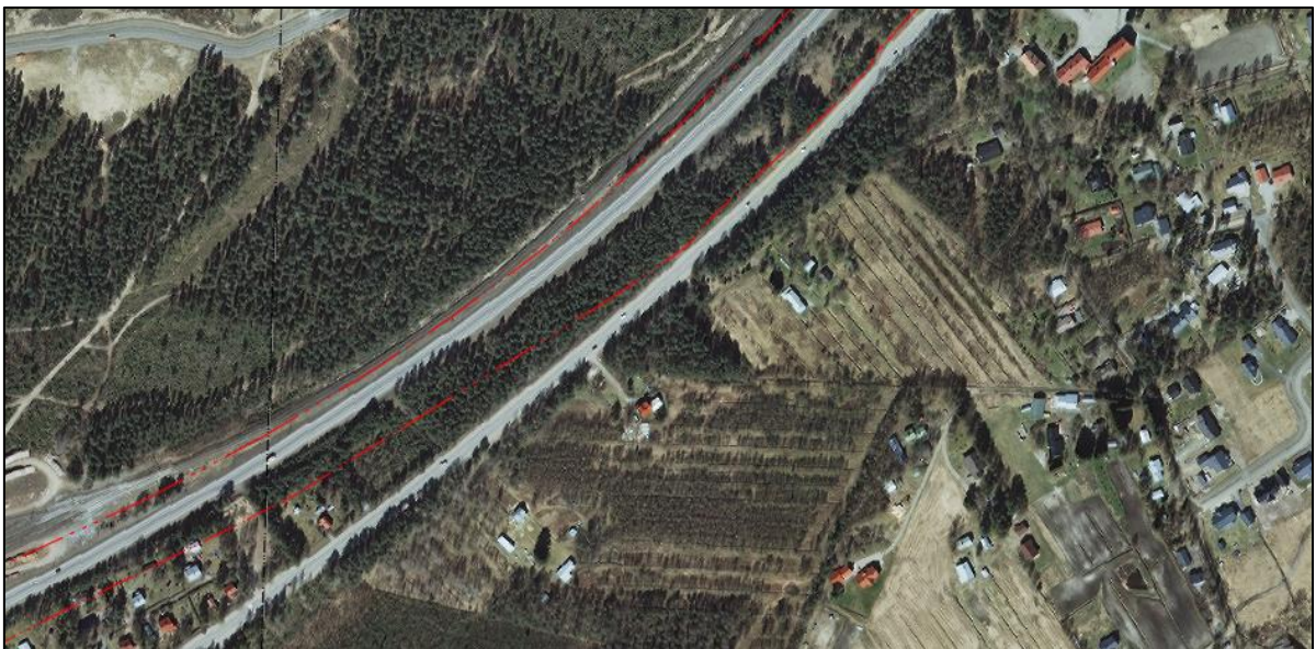
Kuvat 12 ja 13. Kuvissa on ilmakuvat rakennetusta ympäristöstä suunnittelualueelta Liperintien ja Kuopiontien risteyksestä itään.
