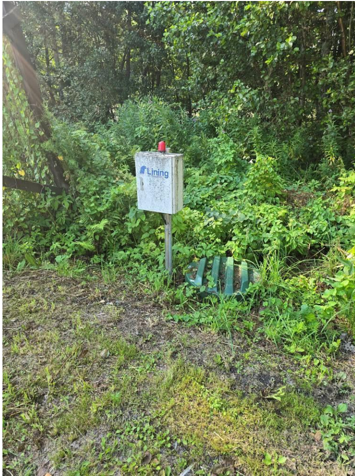
Kuva 8 Kiinteistökohtainen pumppaamo
