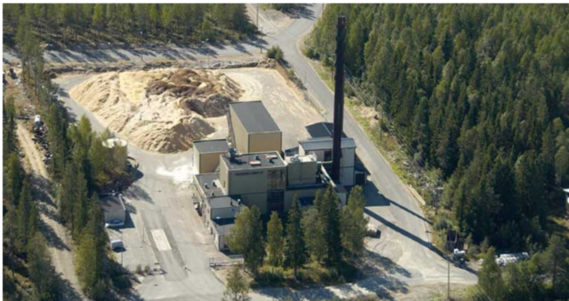
Kuva 5. Nykyinen Ritoniemen lämpölaitos (kuva © Nurmeksen lämpö Oy).
