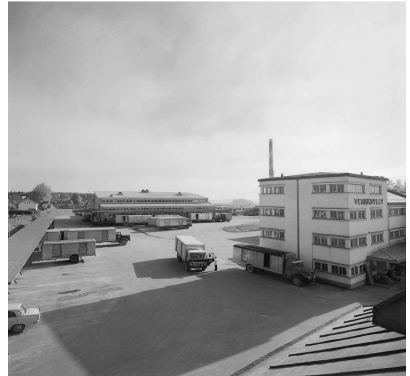
Taustalla vuonna 1962 valmistunut Juustola rakennus, edustalla oikealla Vehnämylly. Kuva Museovirasto.
