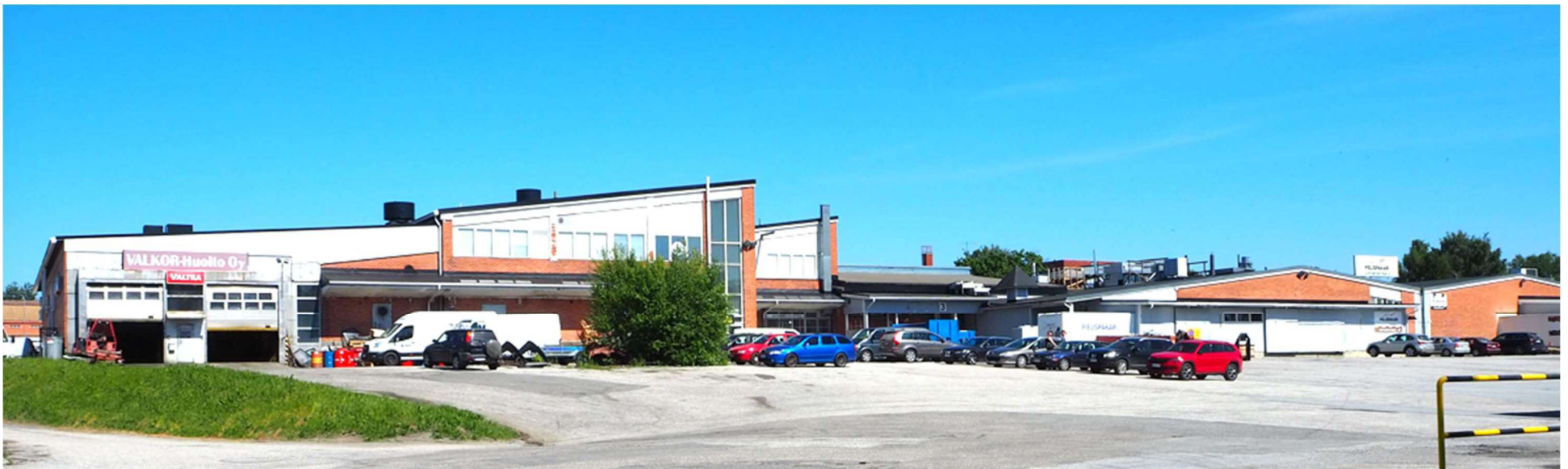
Luoteiskulmasta kuvattu näkymä nykyisestä meijerirakennuksesta, jossa on näkyvillä useina vuosina toteutettujen muutosten kerrostumat.
