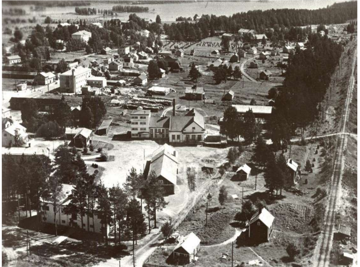
Vuonna 1958 otetussa kuvassa keskellä sijaitsevat 1940 rakennettu Vanha meijeri sekä 1939 valmistunut Vehnämylly. Juustolan rakennuspaikka sijaitsee meijerirakennusten takana, jossa kuvassa sijaitsevat pitkät halkopinorivistöt sekä yksittäisiä pienempiä rakennuksia. Kuva Nurmeksen museo.
