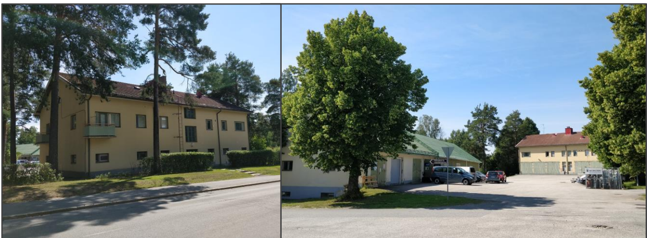
Vasemmalla: Kuva 18. Autotalli-asuinrakennuksen julkisivu Kynsiniemenkadulta kuvattuna. Oikealla: Kuva 19. Rakennuksen sisäpiha ja viereinen varasto/autotallirakennus.
