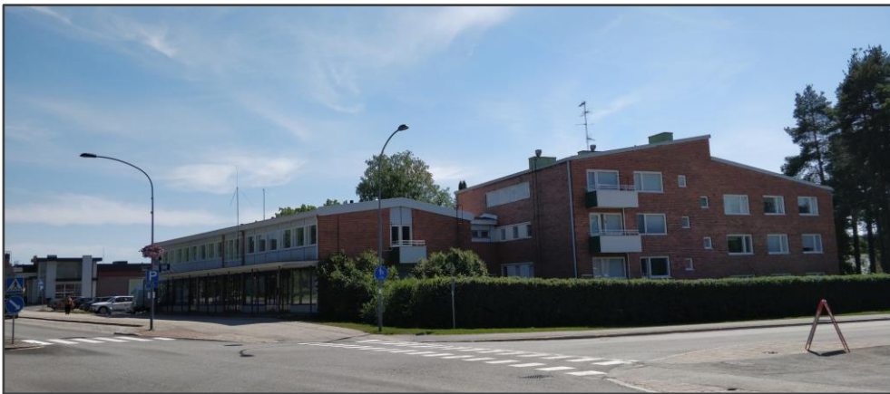
Kuva 17. Asuin- ja liikerakennuksen nykyinen julkisivu Porokylänkadun ja Kynsiniemenkadun kulmassa.
