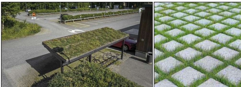
Kuva 7. Viherkatot sopivat hyvin esimerkiksi erilaisten katosten pintamateriaaliksi (vasen. kuva. Lehtovuori). Oikealla kuvassa esimerkki laatoituksesta leveällä saumalla, joka mahdollistaa hulevesien osittaisen imeytymisen maaperään. Usealla valmistajilla on valikoimissaan hulevesikivinä markkinoituja tuotteita (kuva oik. Betonilaatta Oy)
