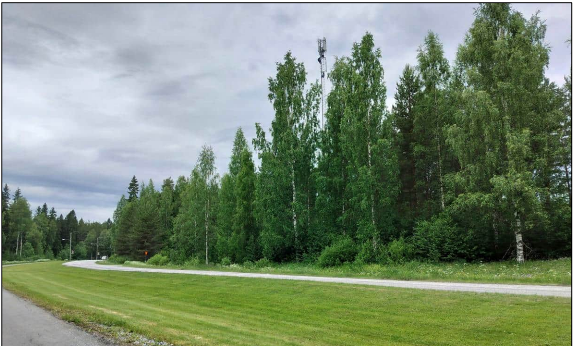
Kuva 4.18 Esa Timosen tie, vasemmalla kävely- ja pyöräilytie. Oikealla tien ja junaradan välinen suojaviheralue ja masto. (Paula Lamminsalo/Sitowise, 2024).
