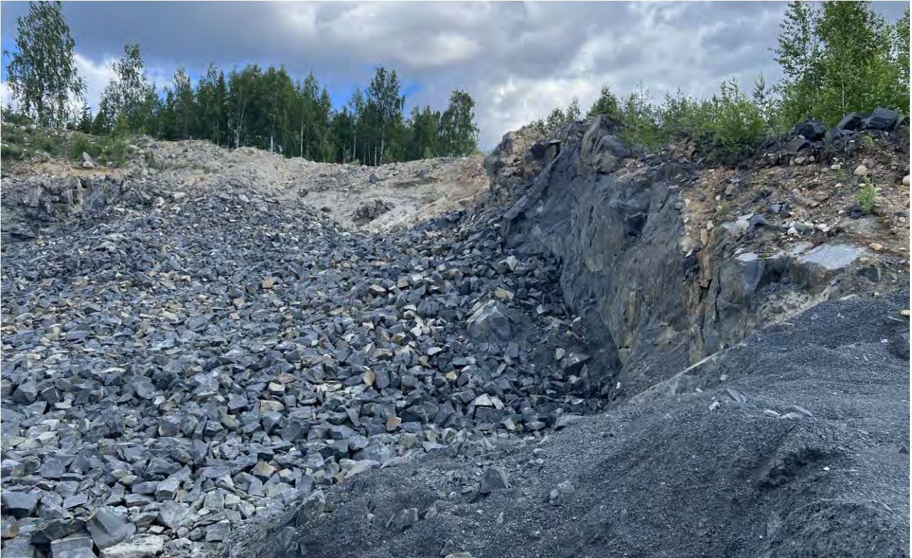
Kuva 8. Näkymä louhitun alueen reunalta pohjoisen suuntaan, etualalla räjäytyksen myötä syntynyt louhekasa. (19.6.2024)
